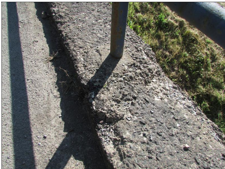
Degradace povrchu římsy
