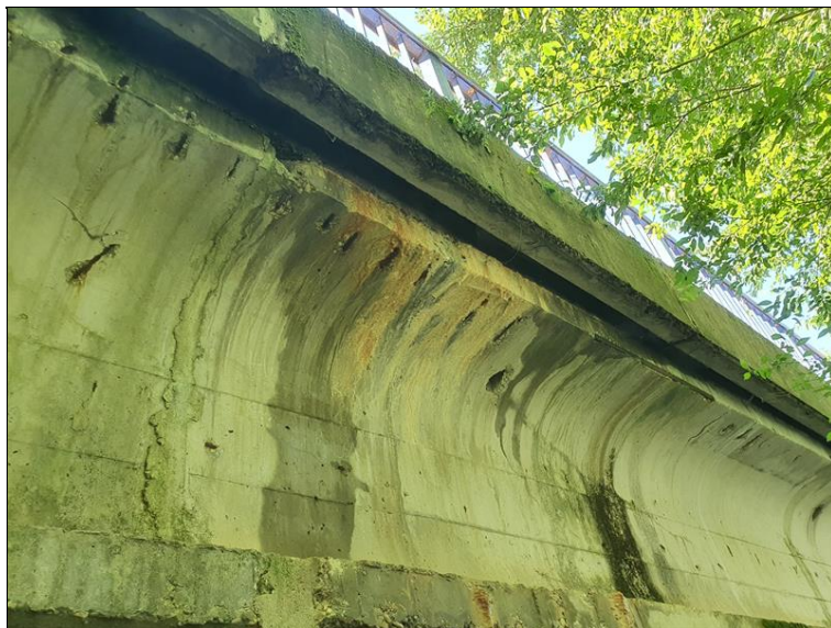
Inkrustace na nosnících
