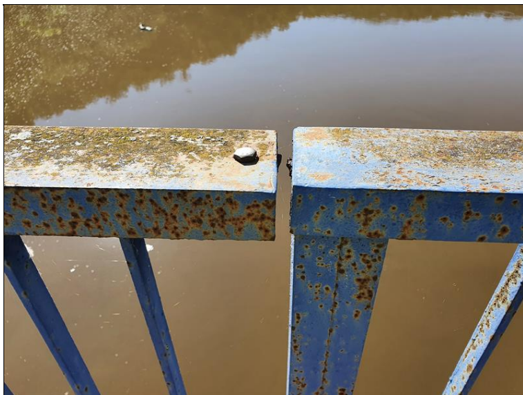
Koroze zábradlí vč. propojení dílů
