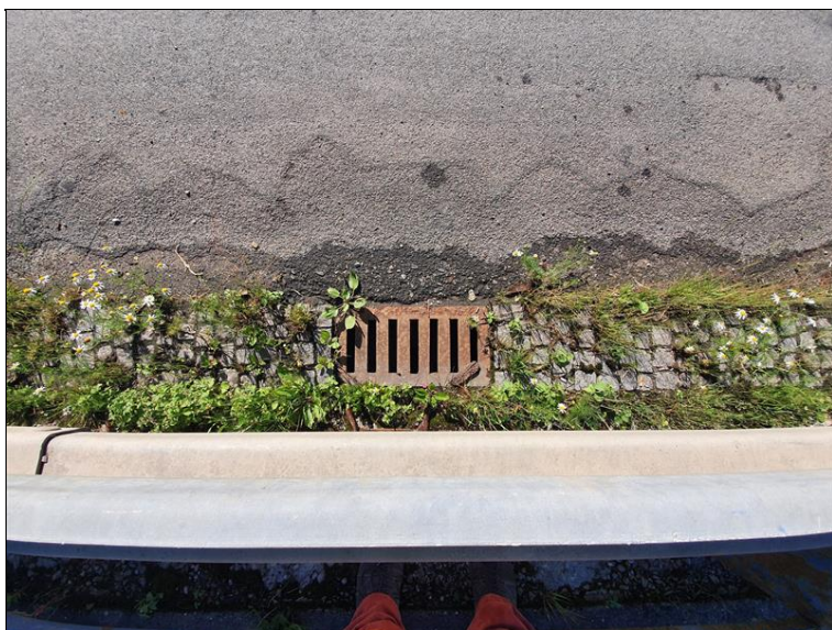
Mostní odvodňovač
