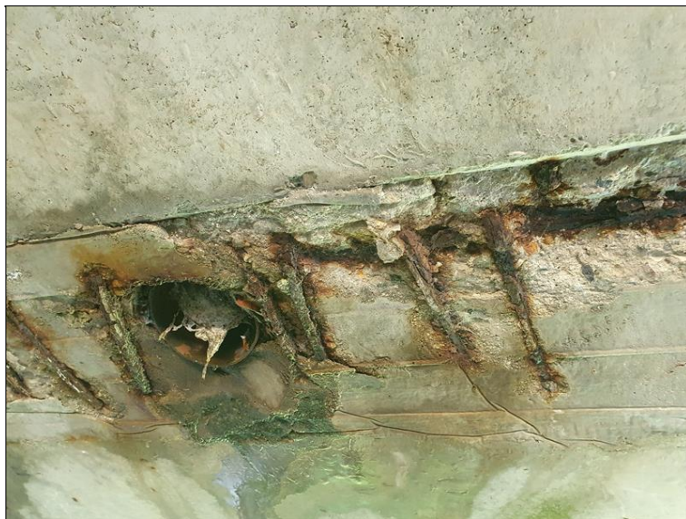
Poškození v místě odvodňovače
