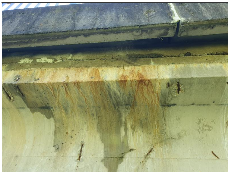
Inkrustace na nosnících
