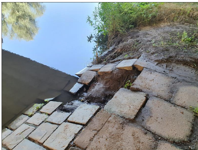
Porušené opevnění
