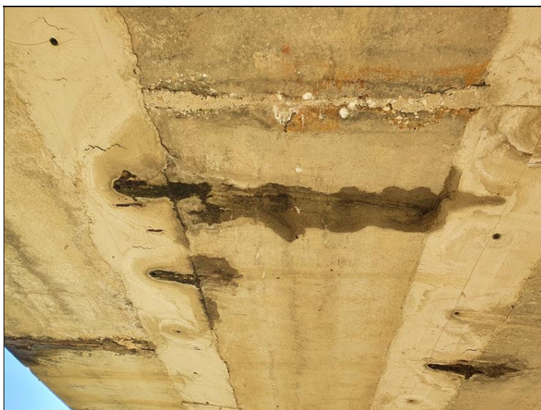
Průsaky nosníků
