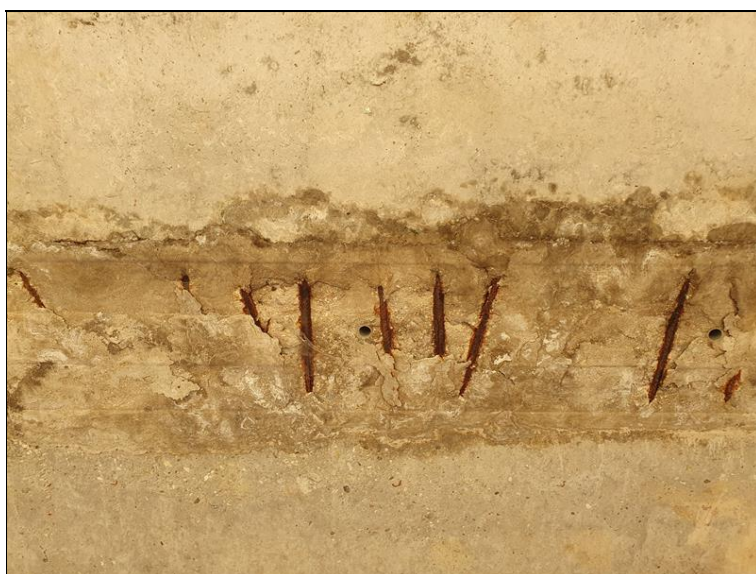
Porušené dobetonávky
