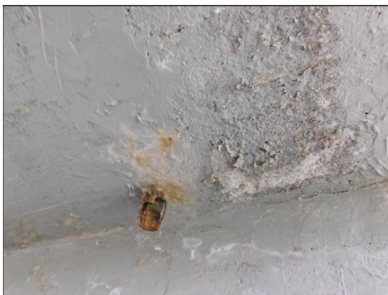
Odvodňovací trubka u O1L, zcela zkorodovaná
