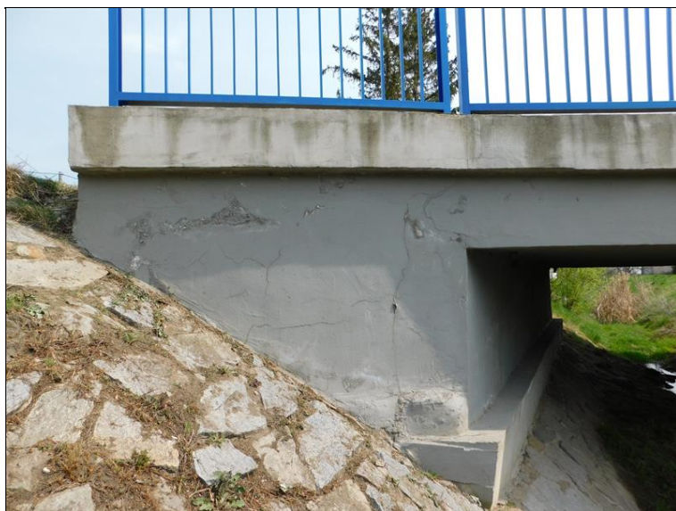
křídlo O1P, trhliny v křídle, lokálně poškozená sanace
