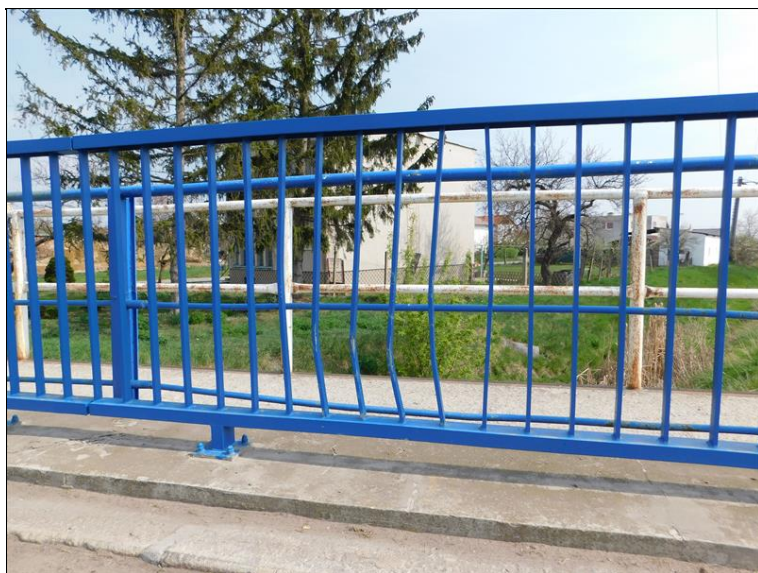
Zábradlí na mostě vlevo, deformace svislých výplní
