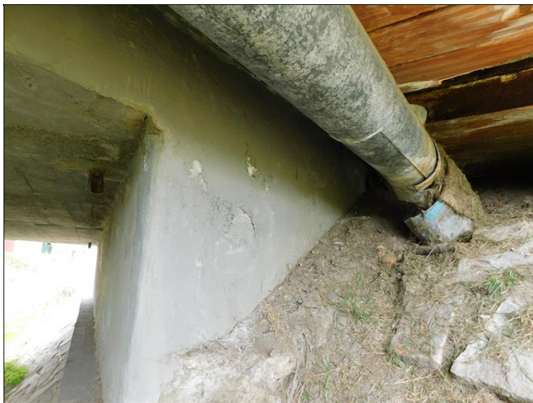
křídlo O1L, olupující se sanace, deformace trubního vedení
