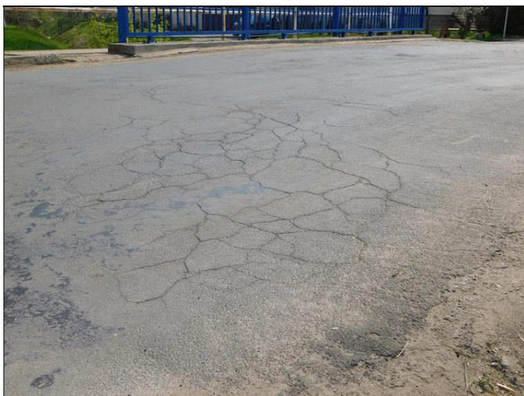
Mozaikové trhliny ve vozovce, živičný povrch zvlněný, oblast nad O1
