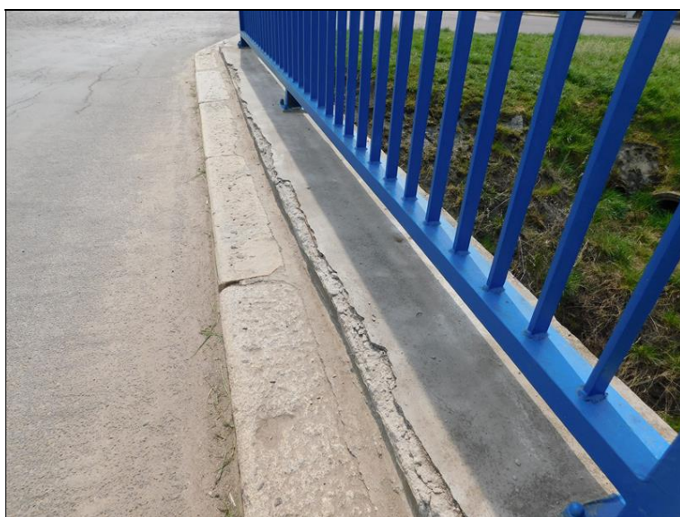
Římsa vpravo, odražení povrchové vrstvy betonu
