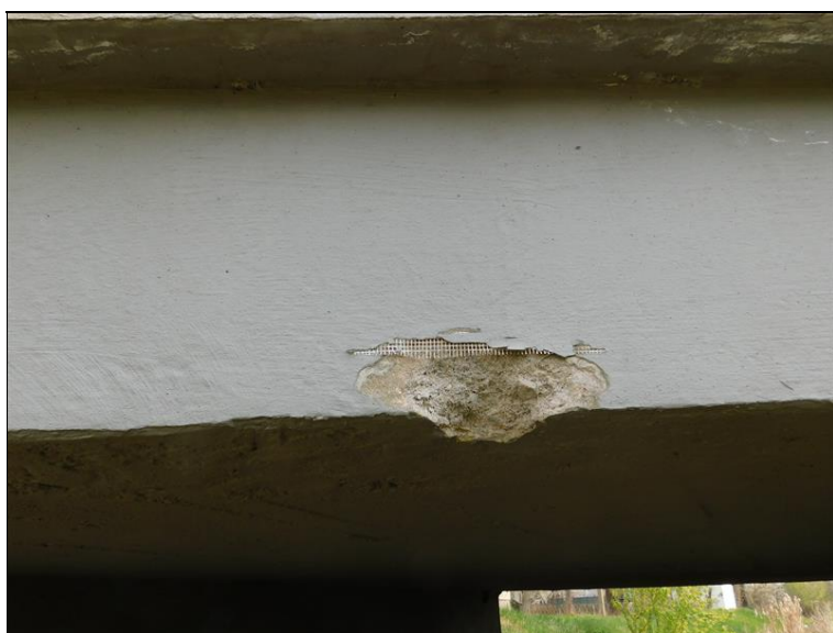
NK zprava - lokálně odražený kus betonu
