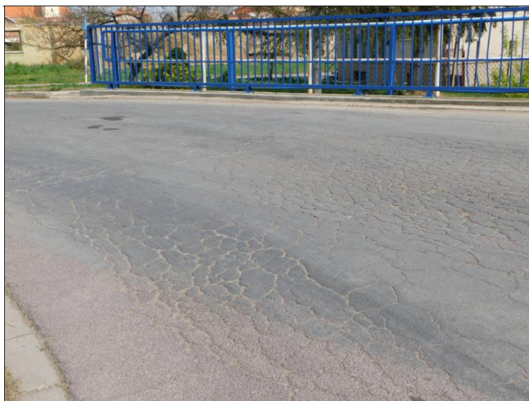
vozovka nad O2, živičný povrch zvlněný, mozaikové trhliny
