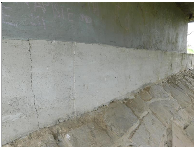
Opakující se svislé trhliny v soklu obou opěr
