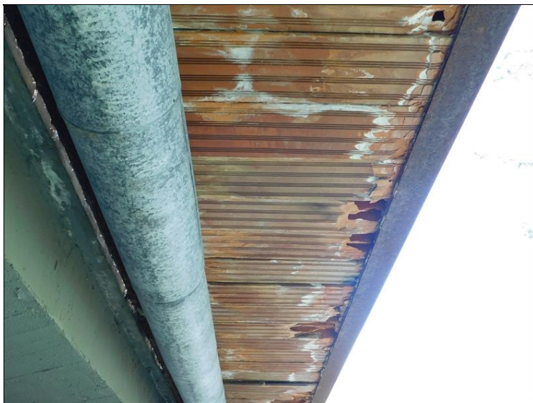
Lávka pro pěší, podhled, keramické vložky degradují - hrozí lokální propad!
