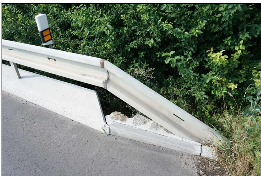
Detail pravé strany u opěry OP1, trhliny v návaznosti římsy, nevhodně napojené svodidlo.
