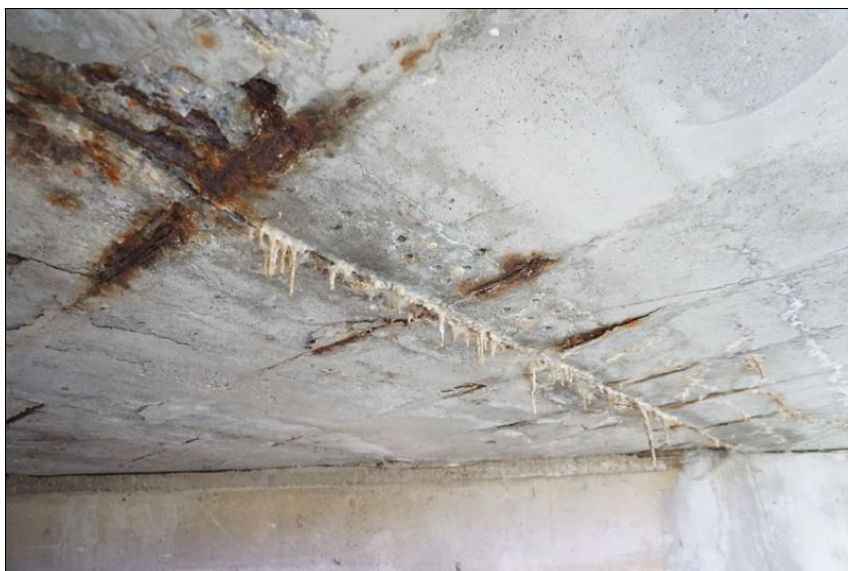
Detail pravých krajních nosníků nosné konstrukce - odpadávající vrstvy betonu až na nosnou výztuž, která silně koroduje.
