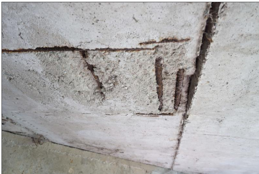
Detail pohledu nosné konstrukce, vyztupující korodující výztuž.
