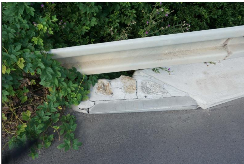
Detail pravé strany u opěry OP2, trhliny v návaznosti římsy, nevhodně napojené svodidlo.
