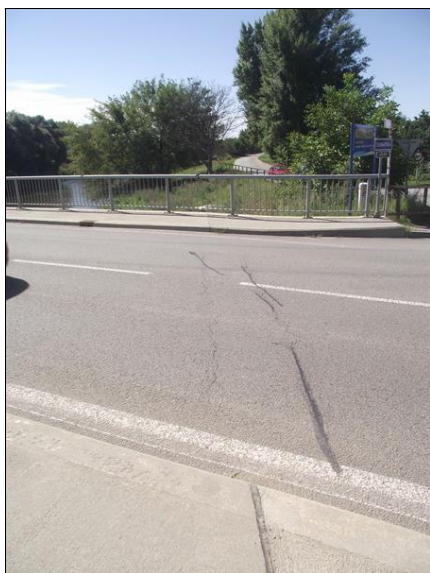
Celkový pohled na podpovrchový závěr u OP1. Příčná trhlina nad MZ, dilatace zábradlí.
