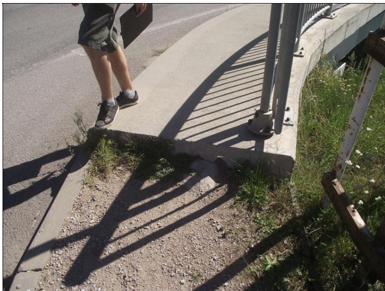
Celkový pohled na podpovrchový závěr u OP1. Příčná trhlina nad MZ, dilatace zábradlí.
