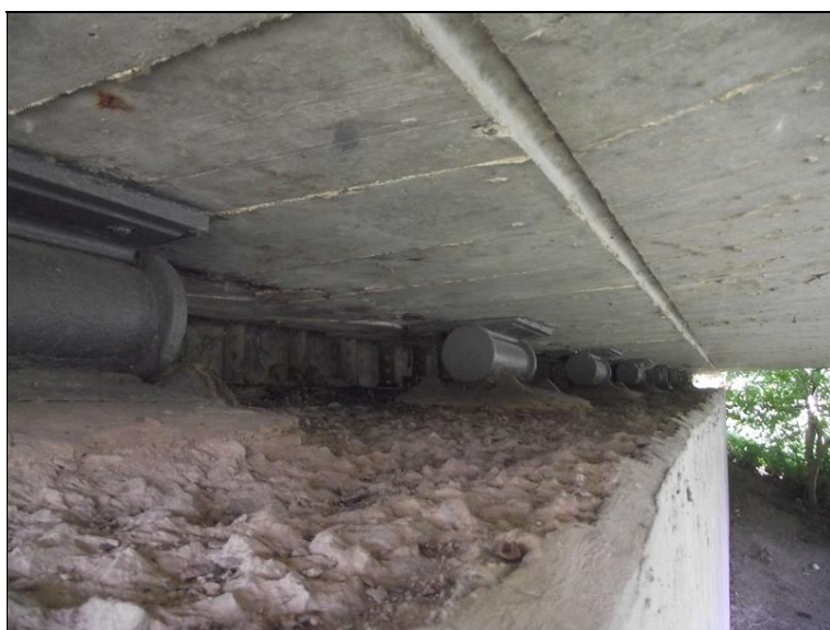
Detail úložného prahu u opěry OP1.
