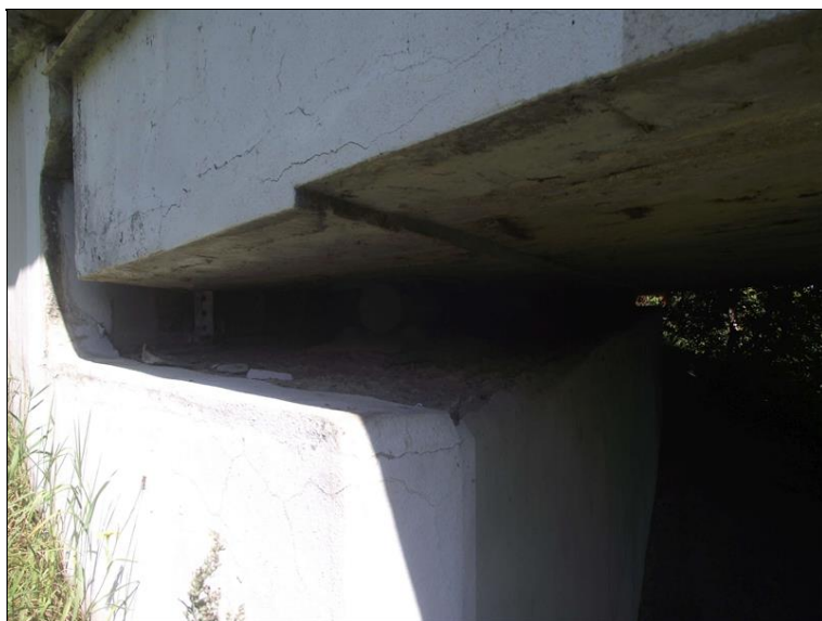
Detail úložného prahu u opěry OP1. Trhliny v sanační omítce.
