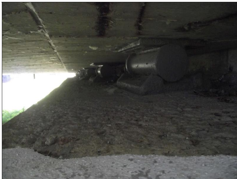
Detail úložného prahu u opěry OP1.
