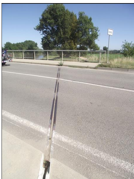
Celkový pohled na povrchový závěr u OP2. Je zanesený. U levého chodníku je uchycená vegetace.
