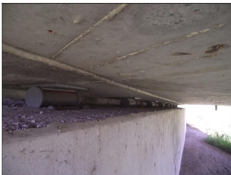
Detail úložného prahu u opěry OP4. Ložiska jsou natřená.
