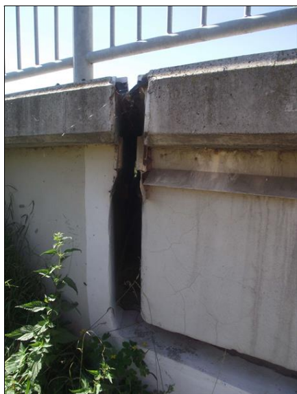
Detail ukončení dilatace levého chodníku nad OP4.
