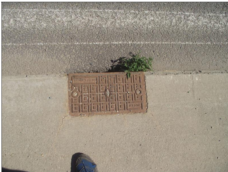
Detail vpusti obrubníkového odvodňovače. Na kraji je uchycená vegetace.
