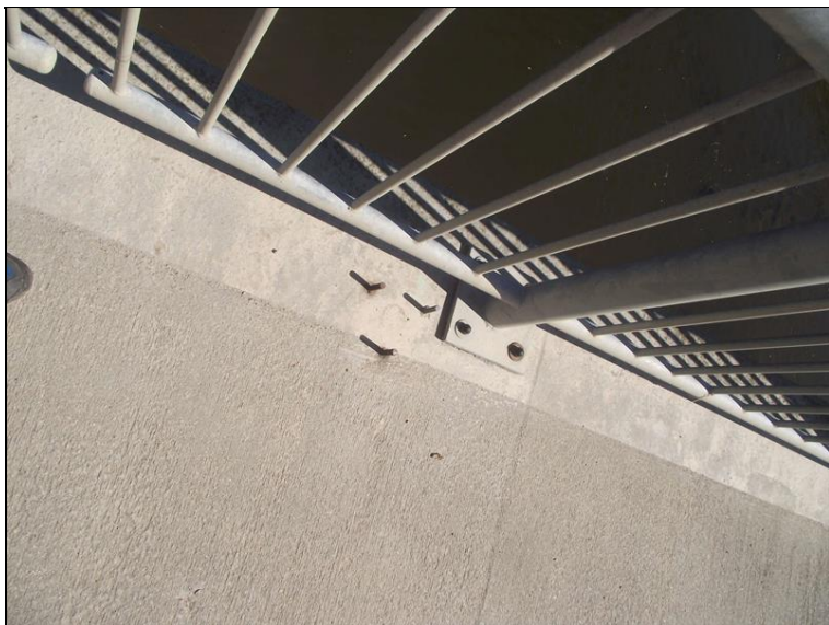
Zbylé kotvy od sloupku s DZ. Levý chodník.
