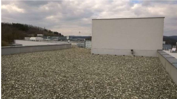
Pohled na střechu – schodišťová nástavba
