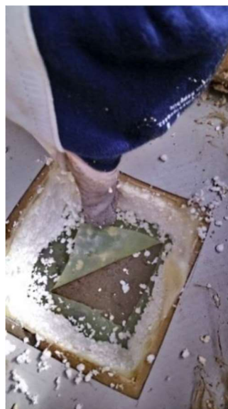
Souvrstv pod PVC (RKNT s.r.o.)
