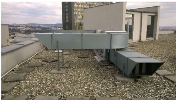
Pohled na střechu – schodišťová nástavba + VZT jednotka
