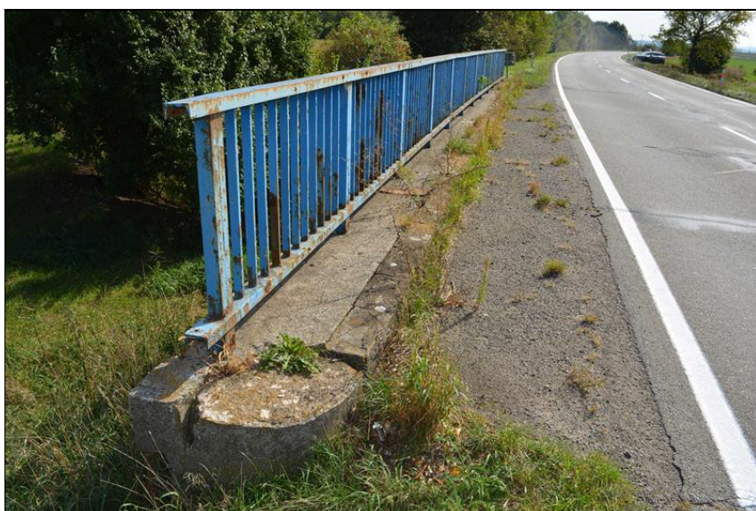
Levá mostní římsa se zábradlím od OP1.
