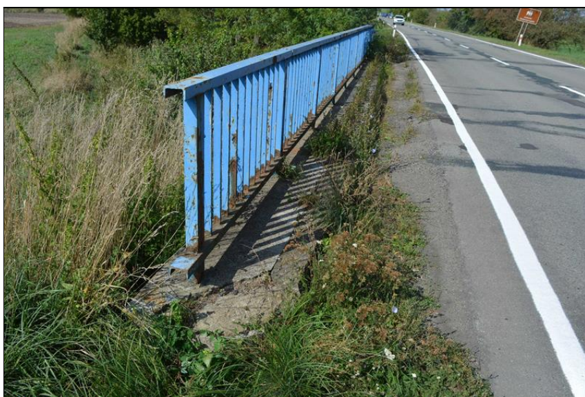
Pravá mostní římsa se zábradlím od OP2.
