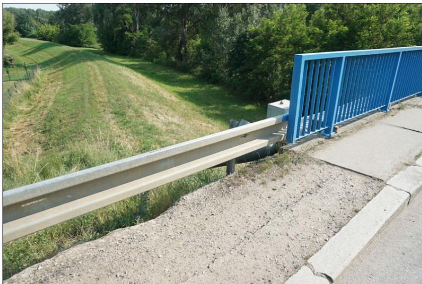
Nevhodná návaznost svodidla na zábradlí na pravé straně u opěry OP4.
