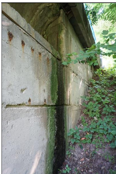
Detail pravé strany opěry OP4 - jasné známky zatékání na úložný prah, následná degradace povrchů.
