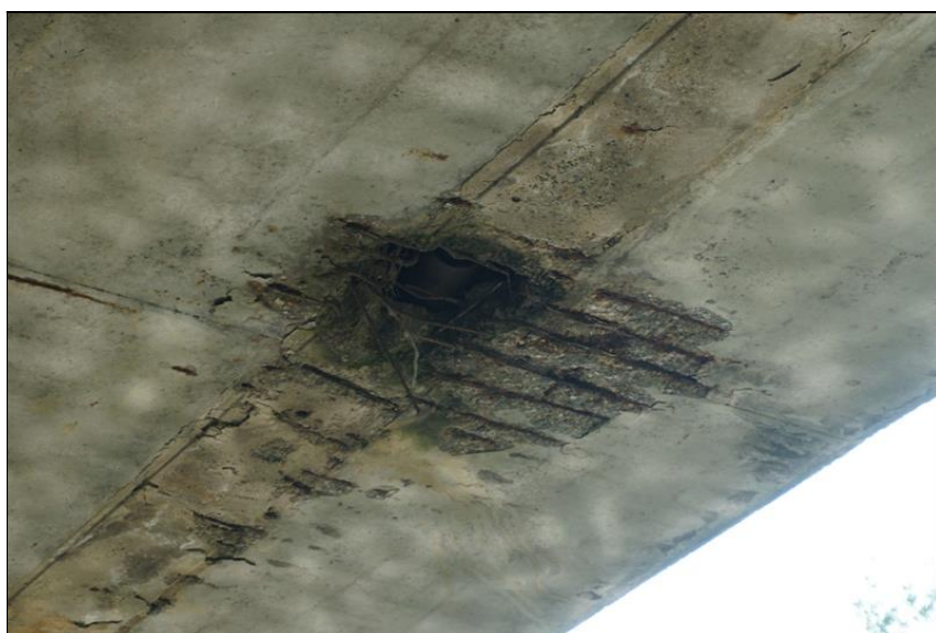
Detail odvodňovače - totální degradace okolí odvodňovačů
