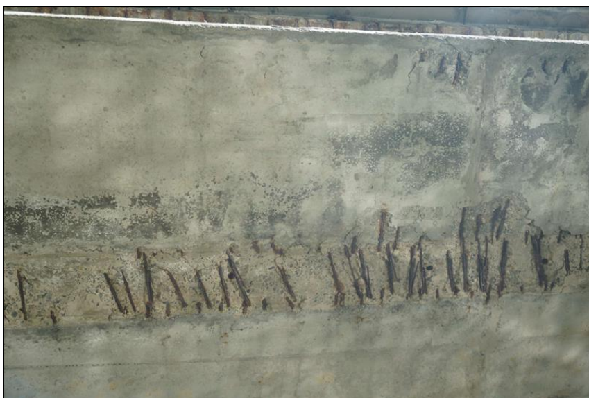
Detail styku nosníků, nízká kvalita betonu, následný rouzpád a koroze oceli.
