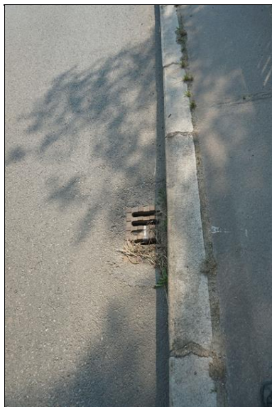
Detail odvodňovače na pravé straně u opěry OP1.
