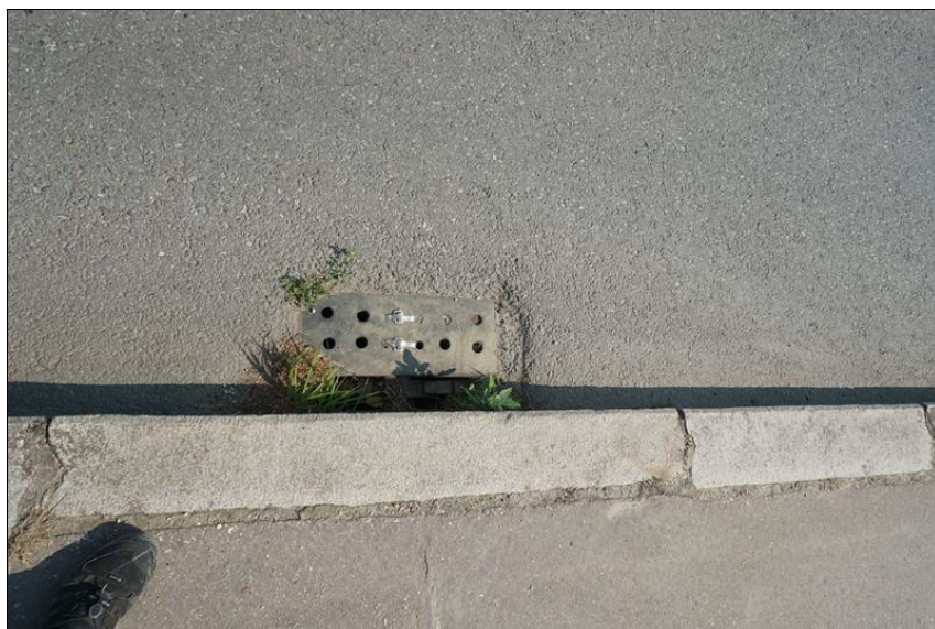
Detail odvodňovače na pravé straně u piliře P2. Mřížka nahrazena děrovaným plechem.
