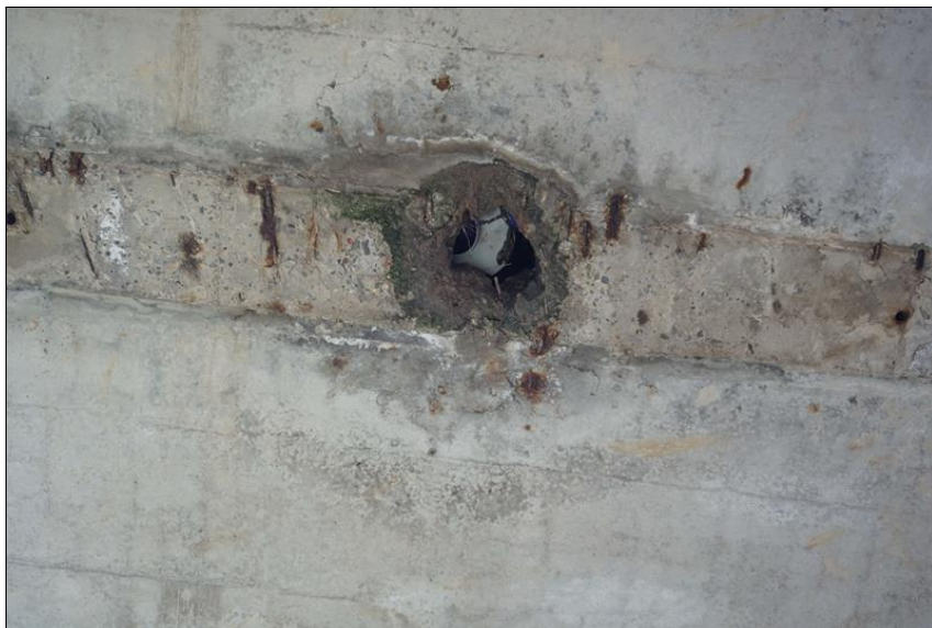
Detail odvodňovače - totální degradace okolí odvodňovačů
