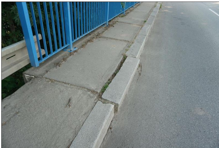
Příčné trhlina v místě závěru u opěry OP1.
