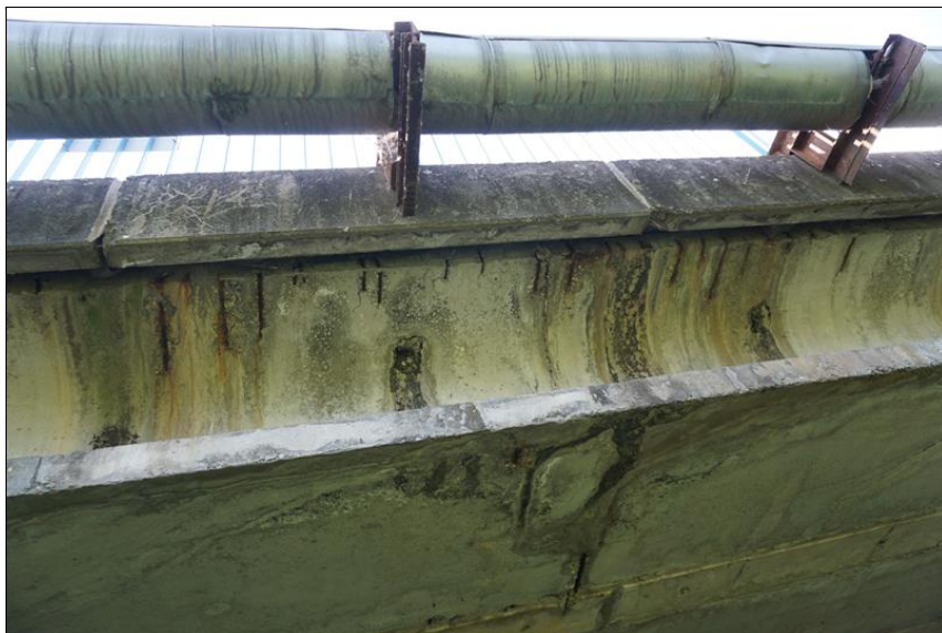
Podhled levého okraje pole 3. - stopy po zatékání, odpadávající vrstvy betonu až na nosnou výztuž, která koroduje.
