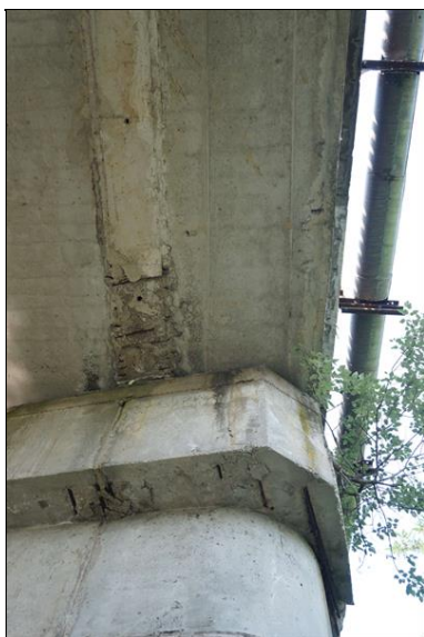
Podhled pilíře a krajního styku nosníku. Degrace povrchu, vystupující výzutž, která koroduje,
