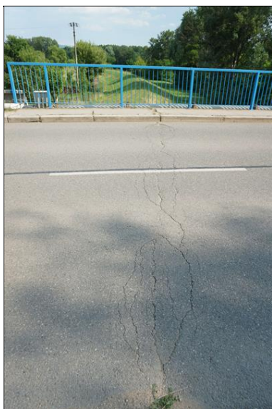
Příčné trhlina v místě závěru u opěry OP1.
