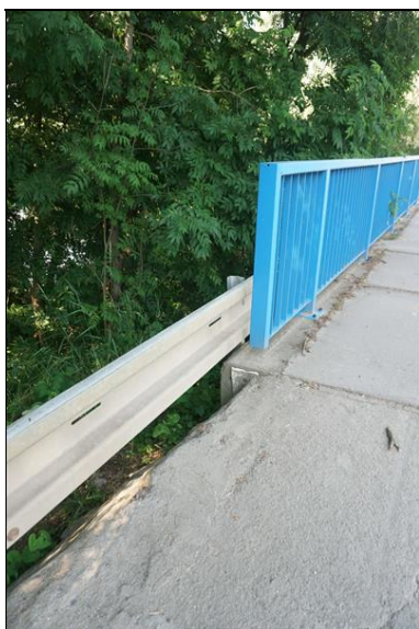
Nevhodná návaznost svodidla na zábradlí na pravé straně u opěry OP4.
