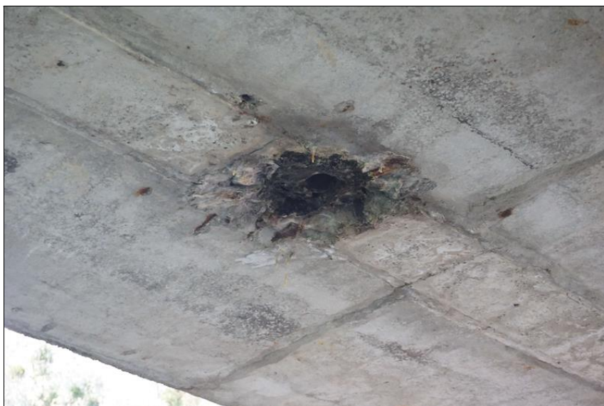
Detail odvodňovače - totální degradace okolí odvodňovačů
