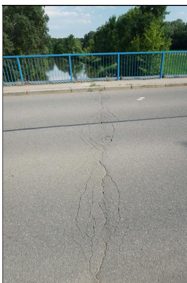
Příčné trhlina v místě závěru u pilíře P3.
