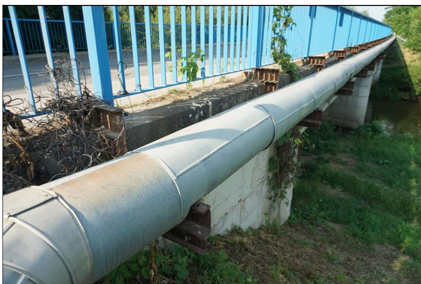
Detail převedeného vodovodního potrubí na levé straně mostu.
