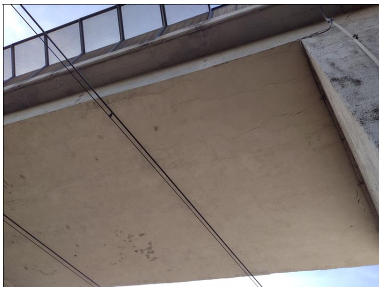
Trhliny na podhledu NK
