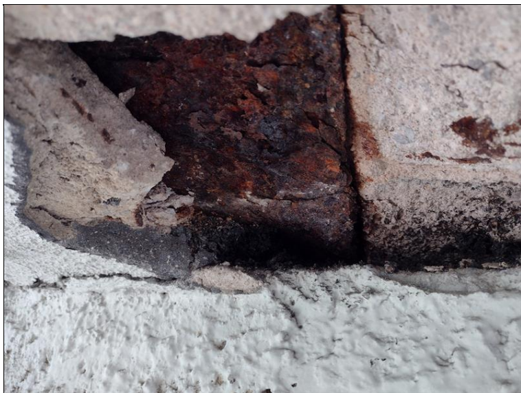
Sonda u OP1 - obnažená korodující dolní příruba ocelového I nosníku
