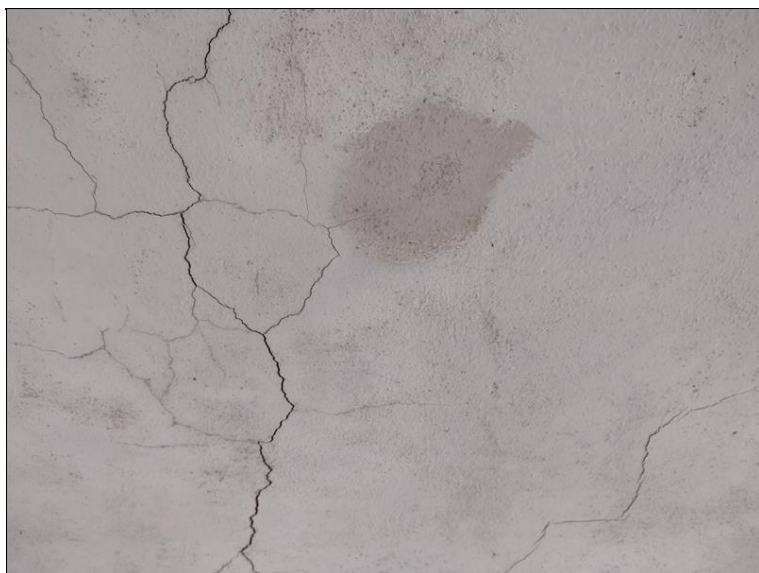
Trhliny na podhledu NK
