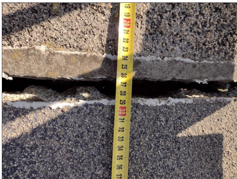
Dilatace v římse za OP2
