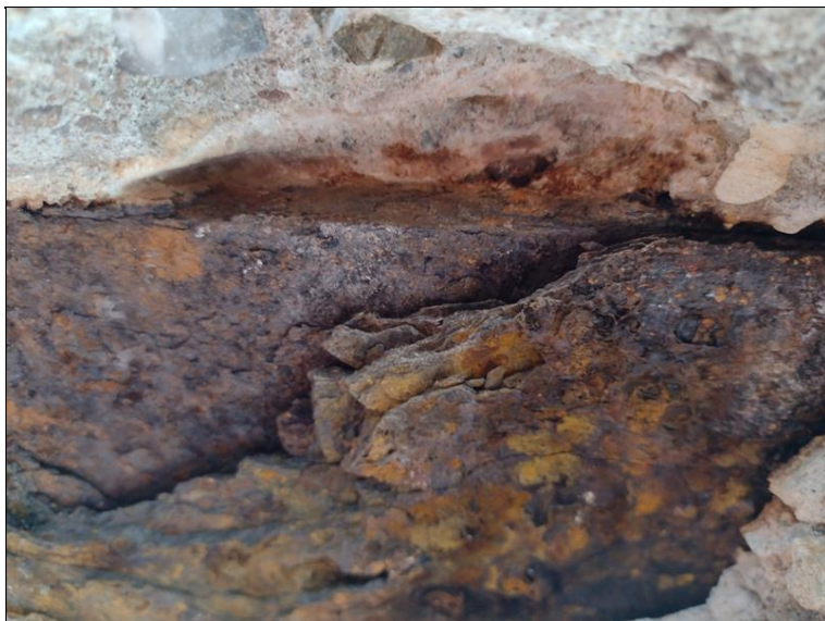
Detail koróze dolní příruby ocelového I nosníku
