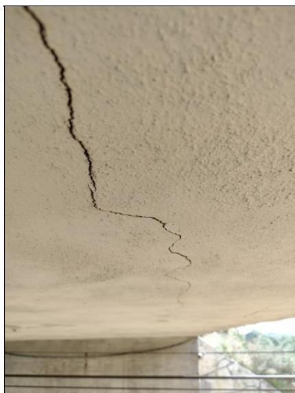
Trhliny na podhledu NK
