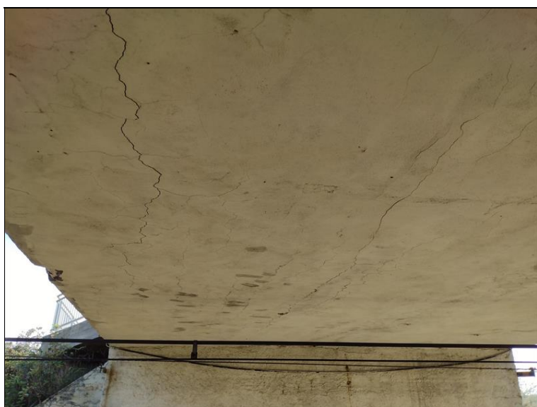
Trhliny na podhledu NK
