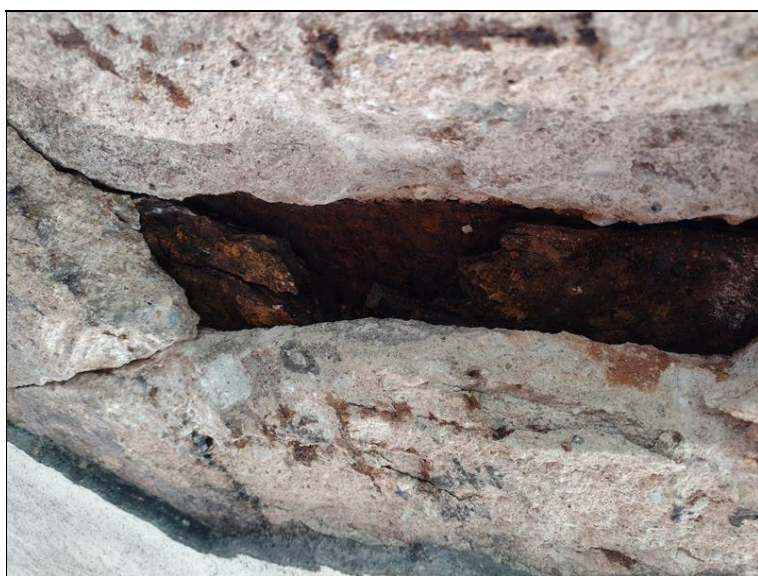
Sekaná sonda v místě trhliny na podhledu NK - zachycen postup provádění sondy
