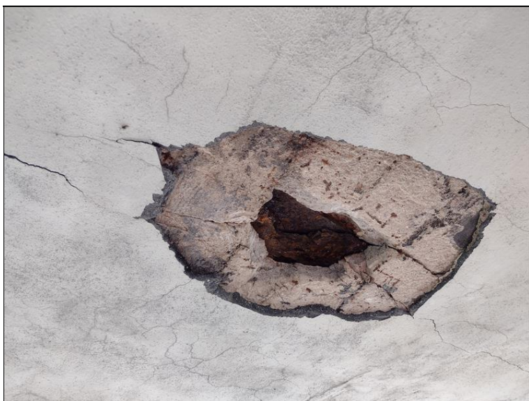
Pohled na provedenou sondu v poli
