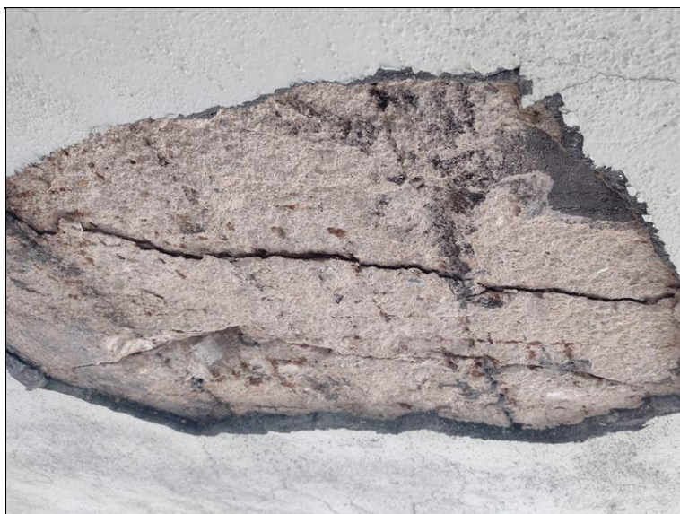
Sekaná sonda v místě trhliny na podhledu NK - zachycen postup provádění sondy
