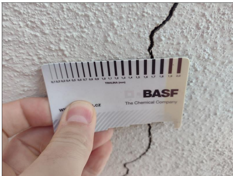
Trhliny na podhledu NK
