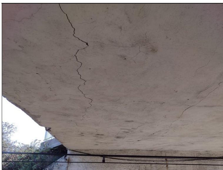
Trhliny na podhledu NK
