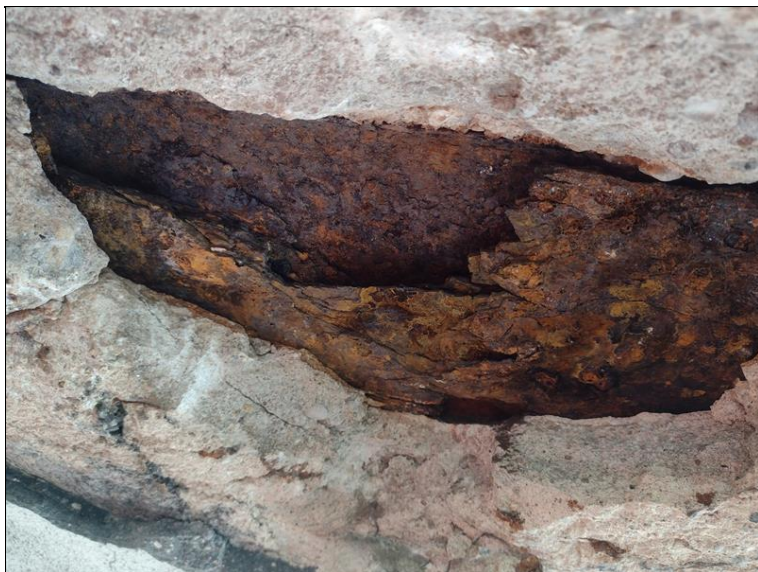
Obnažená dolní pásnice zabetonovaného ocelového I nosníku - silná koróze
