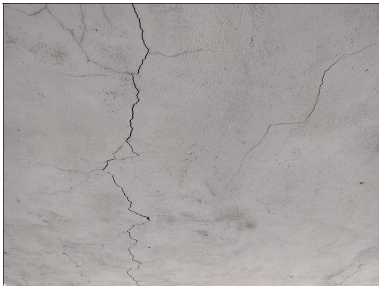
Trhliny na podhledu NK
