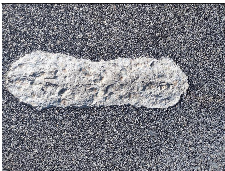
Odloupnutá izolace mostovky, výtluk v betonové desce s trhlinou prokopírovanou i za výtluk
