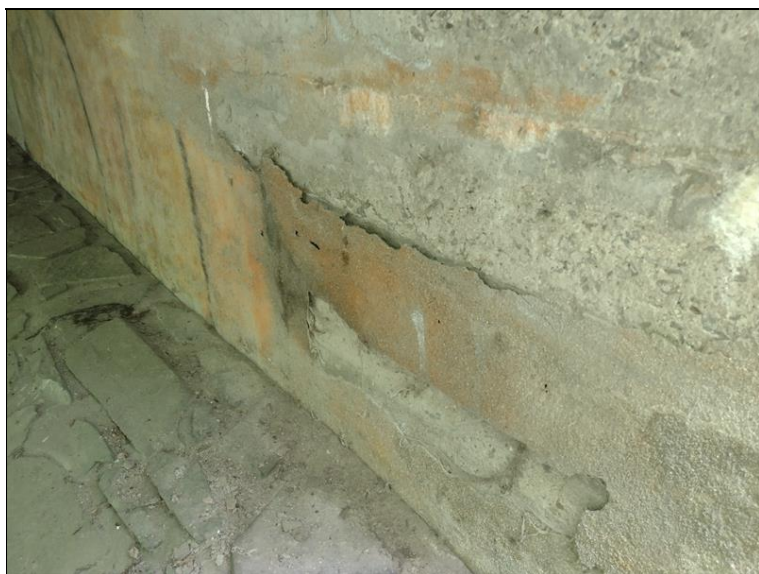
Degradace a odlupování omítky povrchu opěry OP2 vpravo
