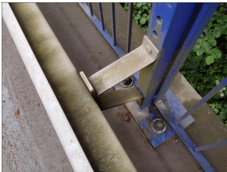
Povrch zádržného systému je pokryt zelenými mikroorganismy
