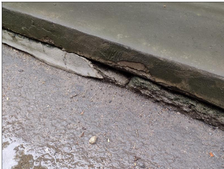
Dobetonávka říms se odděluje od původní římsy, která se rozpadá
