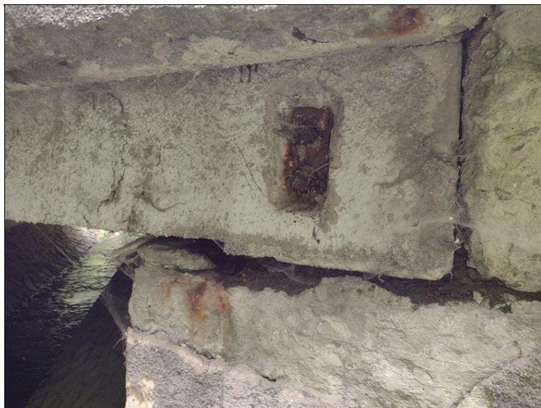
Obnažené korodující kotvy příčného předpětí
