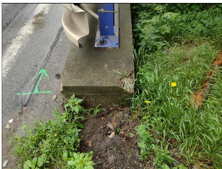
hrany říms jsou olámané a nenavazují plynule na krajnici
