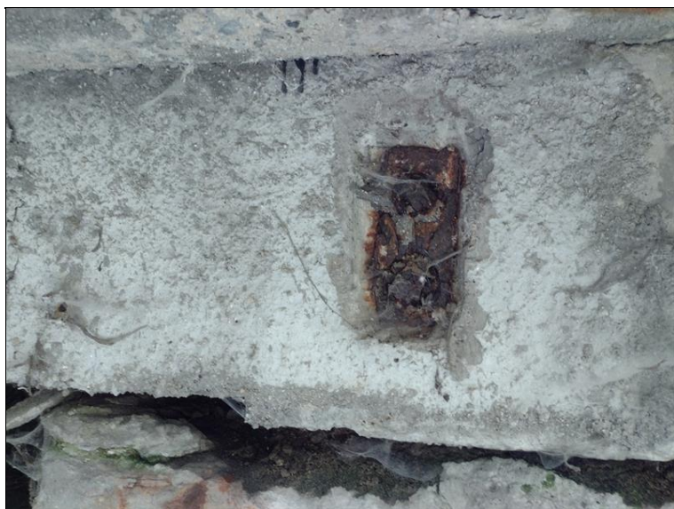
Obnažené korodující kotvy příčného předpětí - detail - nad OP2 vpravo
