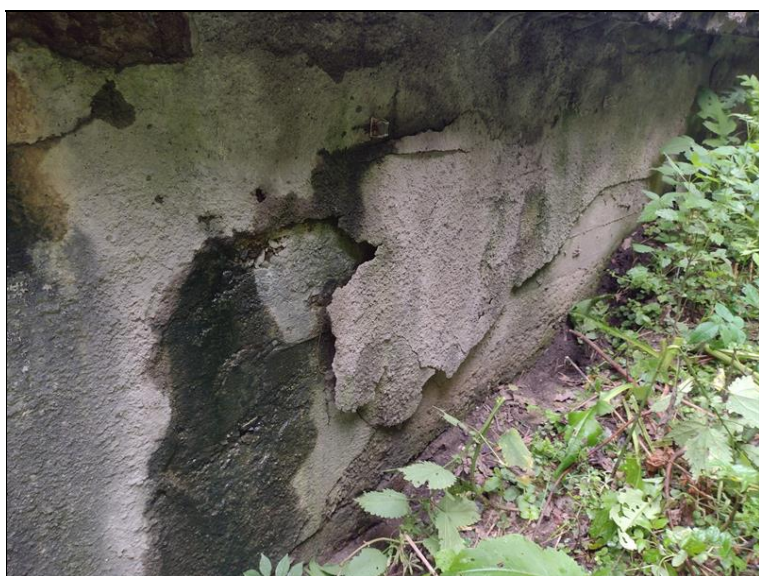
Silná degradace a zatékání na pravé křídlo OP2
