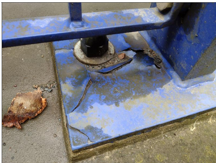
PKO zábradelního svodidla se odlupuje
