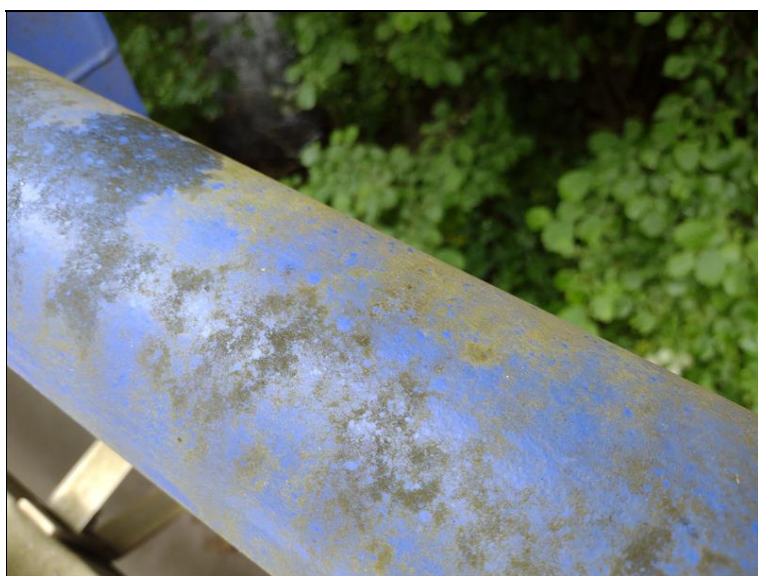
Povrch zádržného systému je pokryt zelenými mikroorganismy
