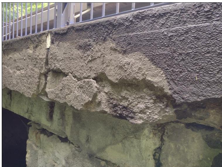
Silná degradace římsy na pravém křídle OP2
