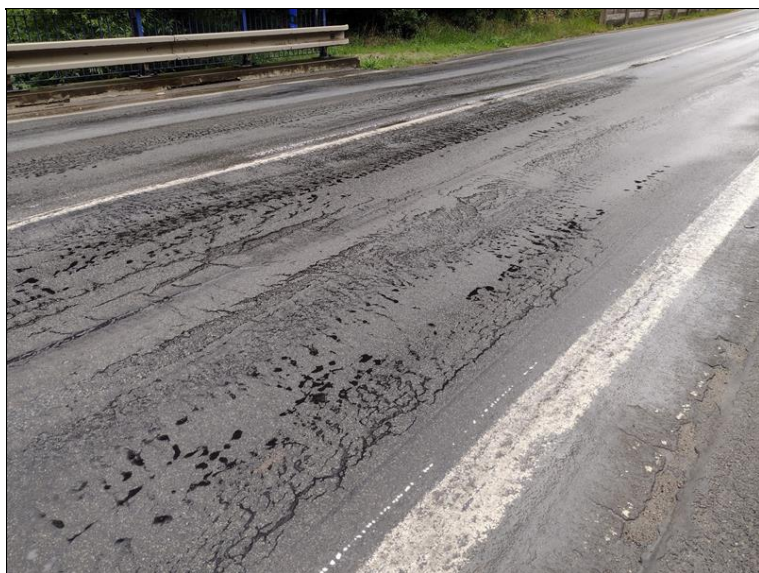
Vozovka s vyjetými kolejemi a trhlinkami
