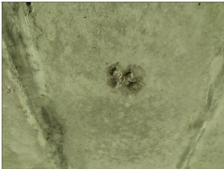
Podhled NK - lokálně odhalená korodující výztuž
