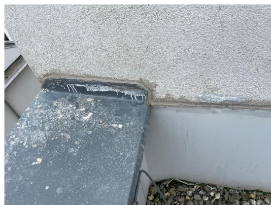
Neošetřené kotvení, netěsnost ukončení atik. oplechování
