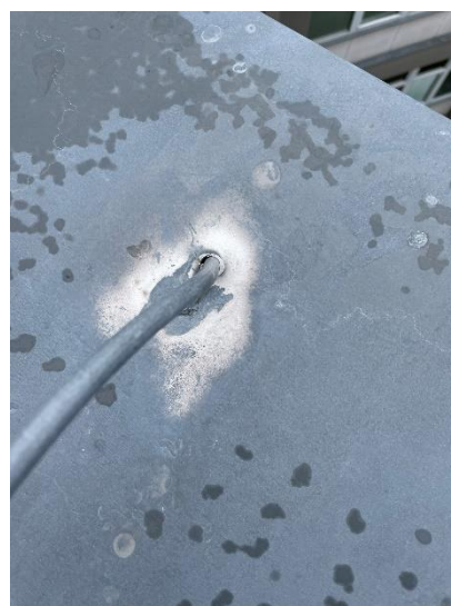
Neošetřený průstup uzemnění atikou
