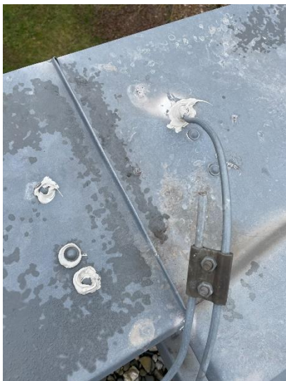
Odbyté utěsnění kotevních prvků na oplechování
