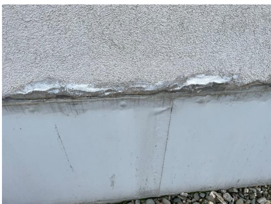
Ukončení PVC je netěsné, po zdi stéká voda za fólii
