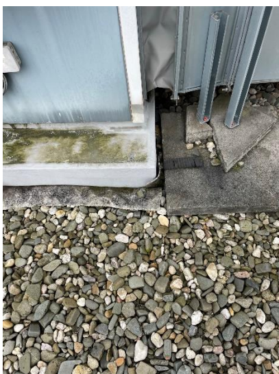
Betonový podstavec VZT nutno lépe vyspádovat
