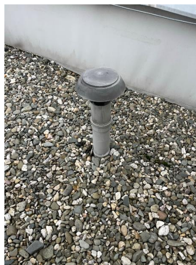
PVC u instal. průstupů končí zároveň s kačírkem
