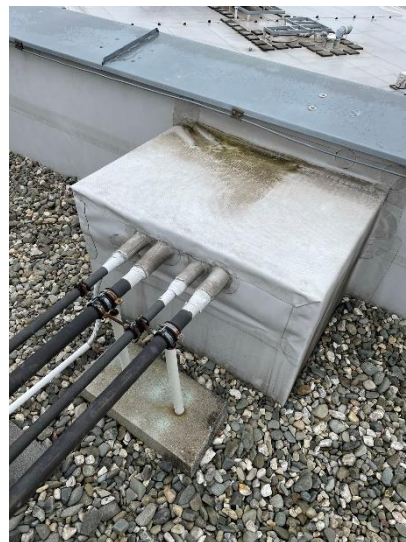
Špatně vyřešeno spádování na instalační lavici
