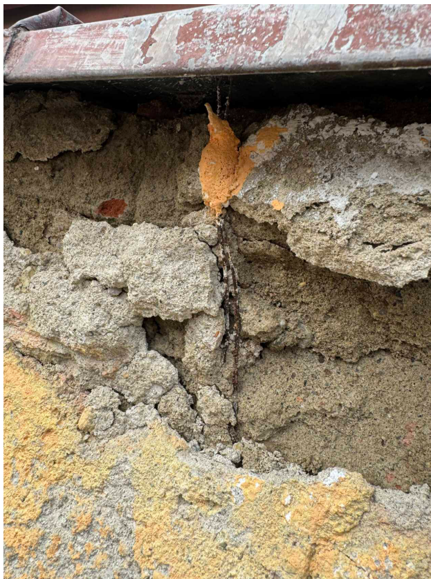
Fotografie č.5 (exteriér) – drátky uchycení oplechování jsou zkorodované.
