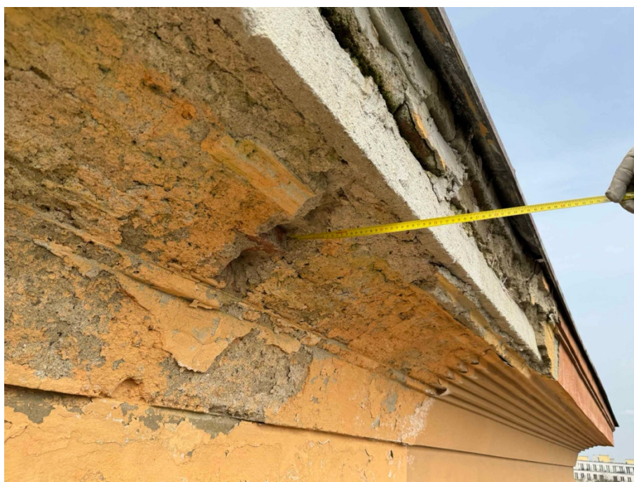
Fotografie č.2 (exteriér) – okapní římsu tvoří cihly plné pálené a beton.
