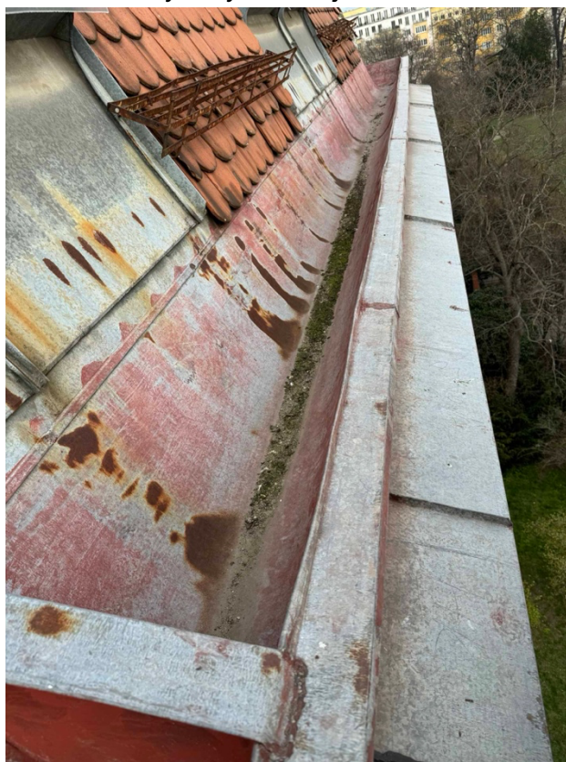
Fotografie č.4 (exteriér) – pohled na oplechování římsy a nástřešní žlab.
