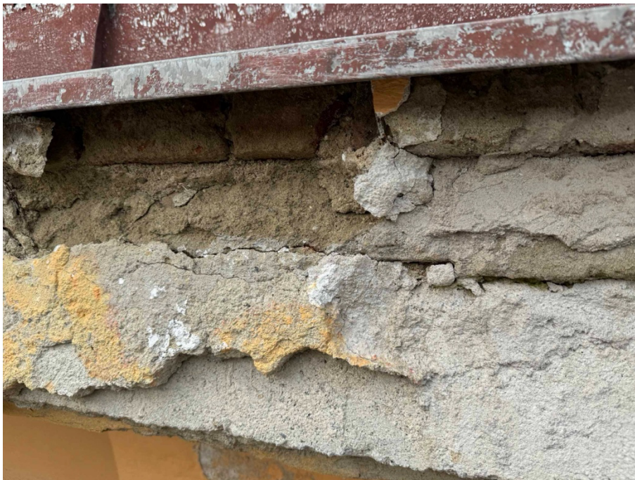
Fotografie č.3 (exteriér) – detail venkovní omítky, která je odpadaná. Drolí se malta mezi cihlami a místy cihly zarůstají mechem.
