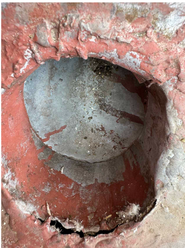
Fotografie č.6 (exteriér) – pohled na poškozené napojení oplechování na svod.
