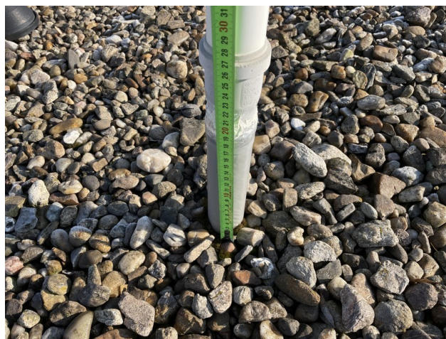
foto/10/ Pohled na ukončení svislého vytažení hydroizolace – výška vytažení cca 270 mm
