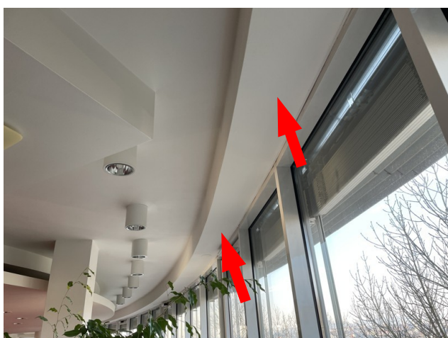
foto/5/ Pohled na kapsu z SDK desek podél rámu oken prosklené fasády
