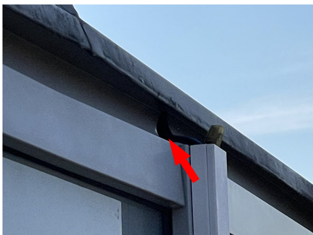
foto/39/ Pohled na prostup kabelové instalace skrz opracování atiky – patrný neopracovaný, netěsný detail
