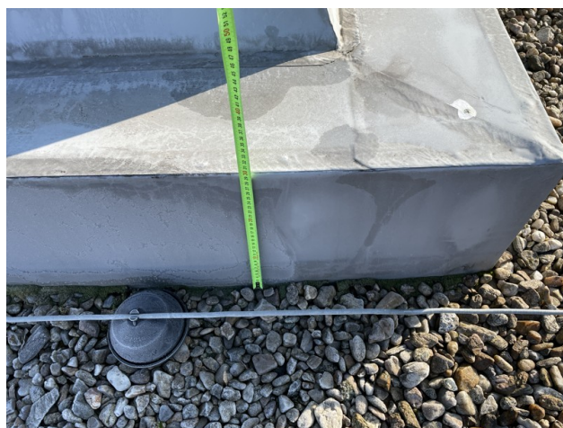
foto/14/ Pohled nástavbu střešního výlezu – vytažení hydroizolace cca 300 mm
