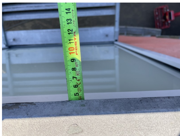
foto/28/ Pohled na vnější přesah oplechování atiky (cca 45 mm)
