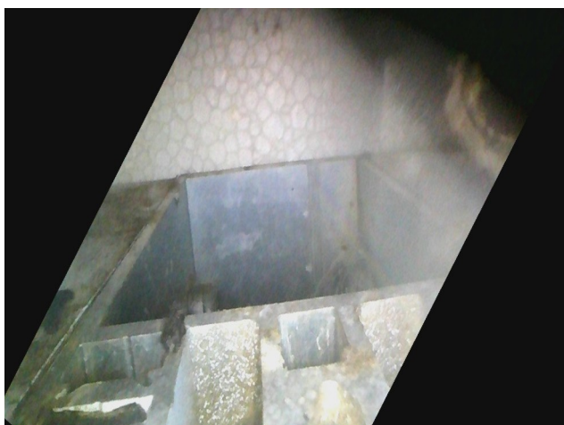
foto/45/ Pohled na rám oken skrz neopracovaný průstup atiky kabelovou instalací – patrné stopy po zatékání
