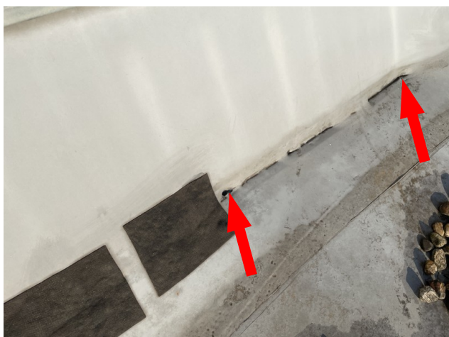
foto/21/ Pohled na perforaci hydroizolační fólie v místě utrženého napojení na atiku
