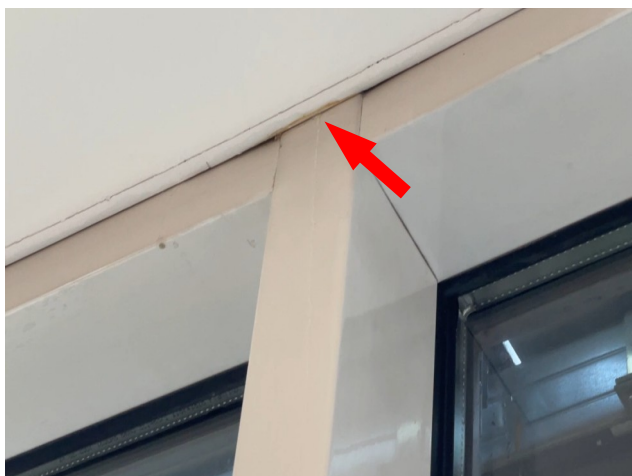
foto/47/ Pohled na vlhkostní poruchy v interiéru v místě styku rámu oken a SDK podhledu – viditelné zatékání při simulaci deště
