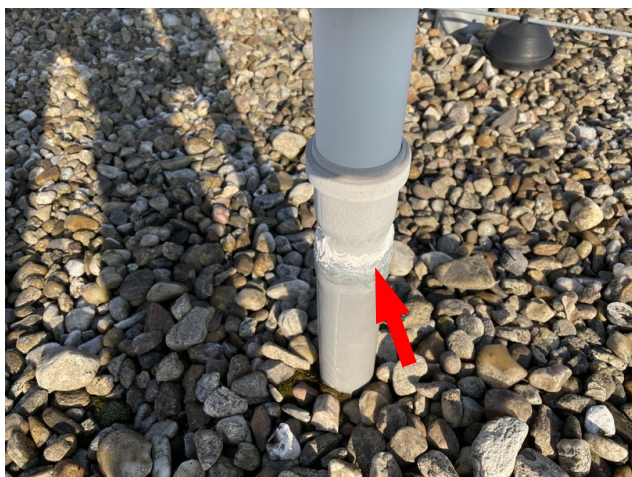
foto/9/ Pohled na ukončení svislého vytažení hydroizolace – patrné dodatečné tmelení
