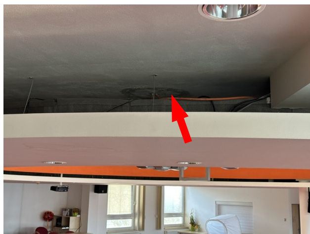
foto/2/ Pohled na vlhkostní poruchy na stropní konstrukci
