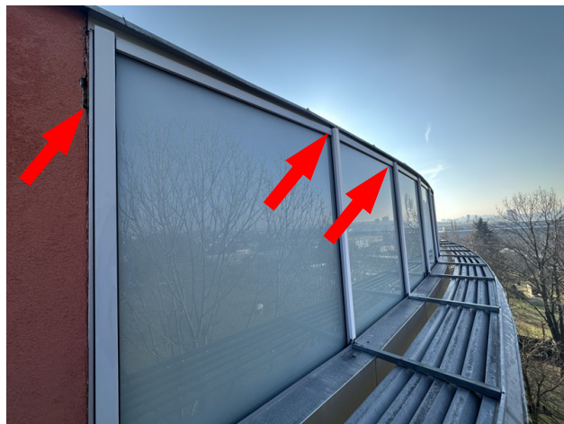
foto/38/ Pohled na horní hranu prosklené fasády – červeně vyznačená problémová místa
