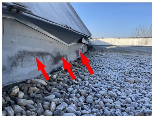
foto/16/ Pohled na znečištění v místě svislého vytažení na konstrukci kruhové kupole
