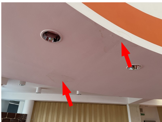
foto/1/ Pohled na vlhkostní poruchy na SDK podhledu
