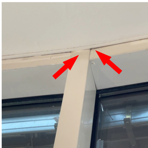
foto/49/ Pohled na vlhkostní poruchy v interiéru v místě styku rámu oken a SDK podhledu – viditelné zatékání při simulaci deště
