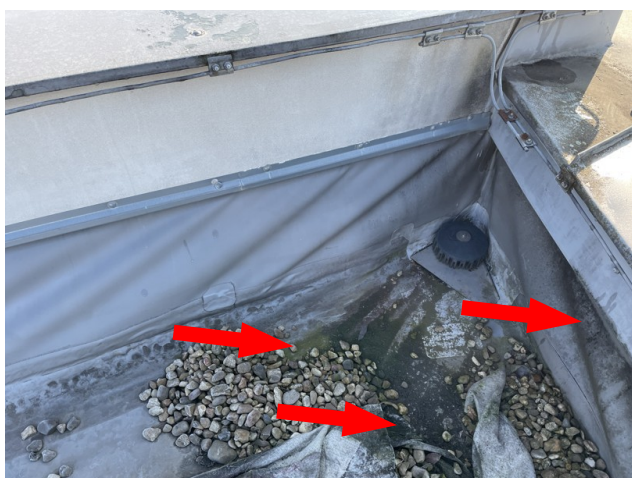
foto/15/ Pohled na biotické znečištění, degradaci a zvlnění hydroizolační fólie v kraji střechy
