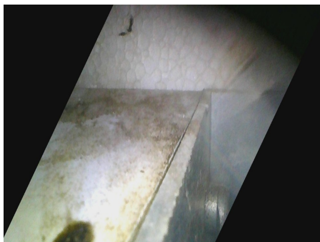
foto/46/ Pohled na rám oken skrz neopracovaný průstup atiky kabelovou instalací – patrné stopy po zatékání
