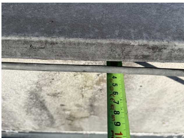
foto/27/ Pohled na vnitřní přesah oplechování atiky (cca 35 mm)
