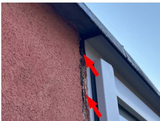
foto/41/ Pohled na ukončení a napojení prosklené fasády na ETICS – patrná svislá trhlina podél rámu oken
