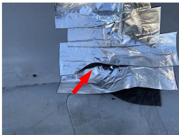
foto/22/ Pohled na netěsnosti v záplatách
