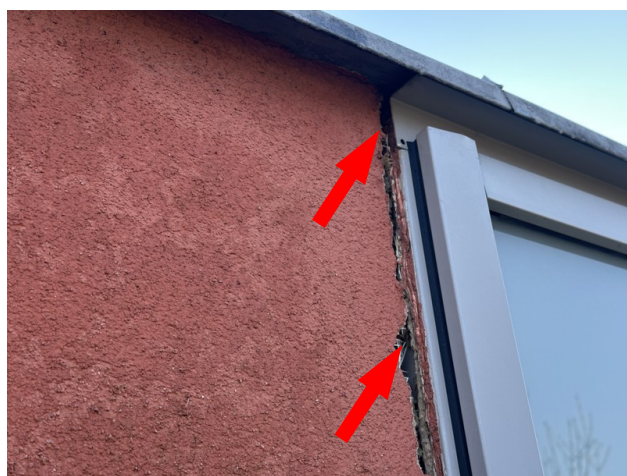
foto/42/ Pohled na ukončení a napojení prosklené fasády na ETICS – patrná svislá trhlina podél rámu oken
