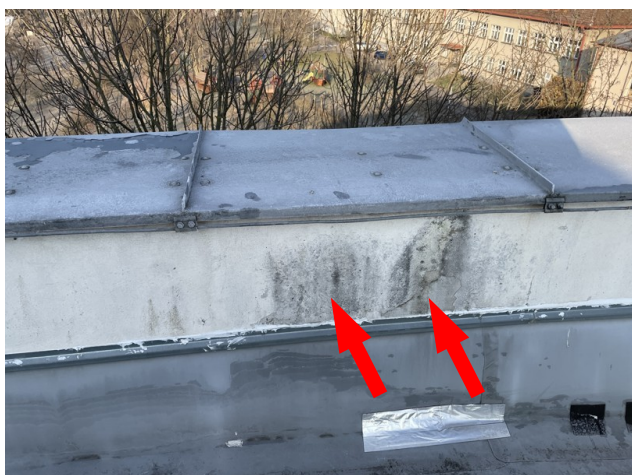
foto/17/ Pohled na degradovanou omítku zdiva atiky – viditelná výztužná tkanina
