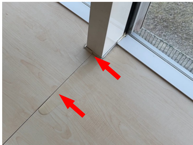
foto/50/ Pohled na vlhkostní poruchy v interiéru – patrné stékání vody po rámu oken až na parapet, kde byly v minulosti pozorované zátoky
