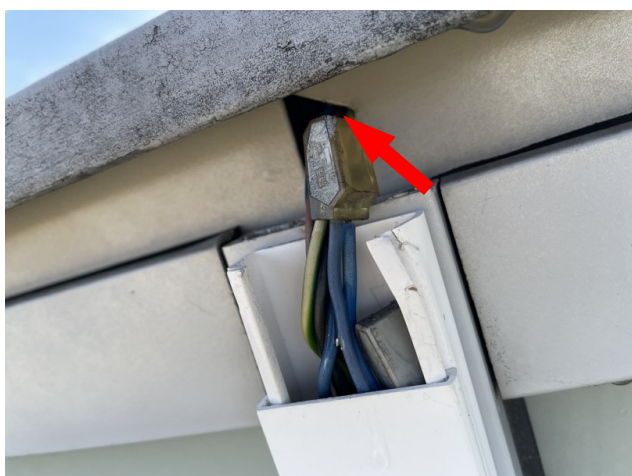
foto/35/ Pohled na prostup kabelové instalace skrz opracování atiky – patrný neopracovaný, netěsný detail
