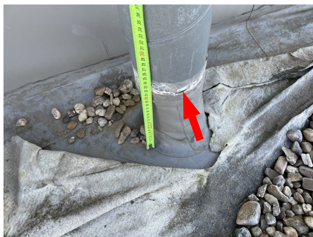
foto/12/ Pohled na ukončení svislého vytažení hydroizolace – výška vytažení cca 210 mm, patrné netěsnosti
