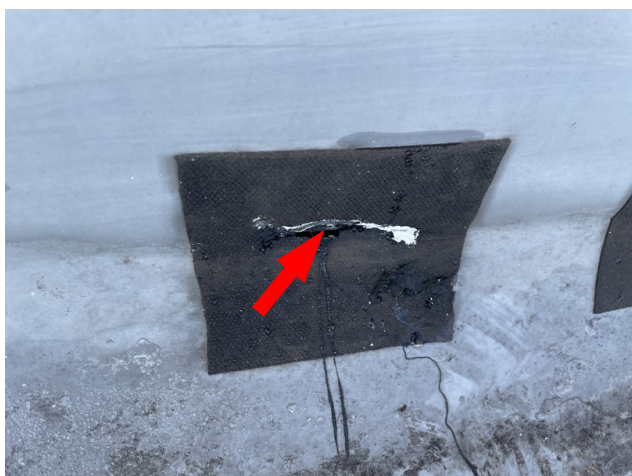
foto/23/ Pohled na netěsnosti v záplatách
