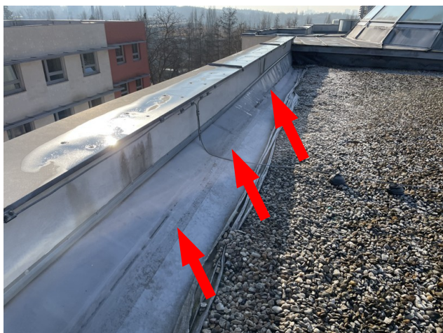
foto/19/ Pohled na utržené napojení povlakové hydroizolační fólie na atiku
