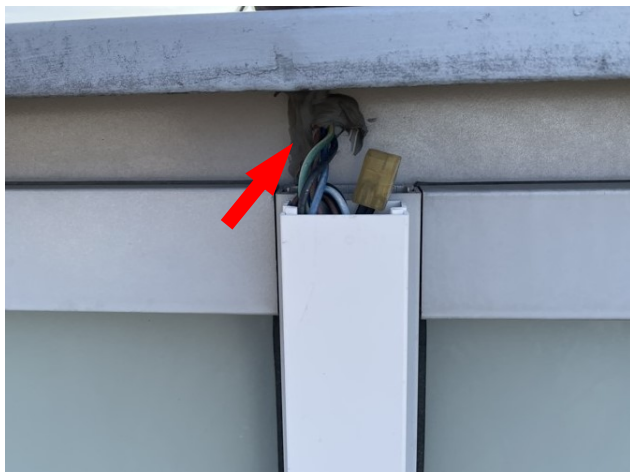
foto/37/ Pohled na prostup kabelové instalace skrz opracování atiky – patrné vytmelení prostupu
