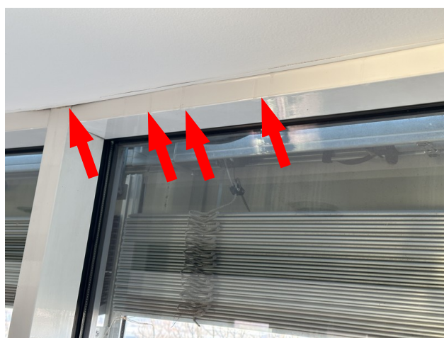
foto/6/ Pohled na zátoky v místě styku rámu oken a SDK desek
