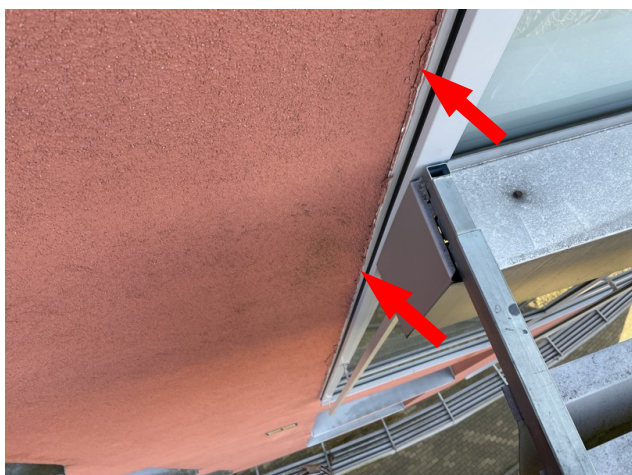
foto/43/ Pohled na ukončení a napojení prosklené fasády na ETICS – patrná svislá trhlina podél rámu oken
