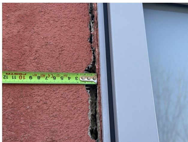
foto/44/ Pohled na ukončení a napojení prosklené fasády na ETICS – šířka trhliny cca 24 mm
