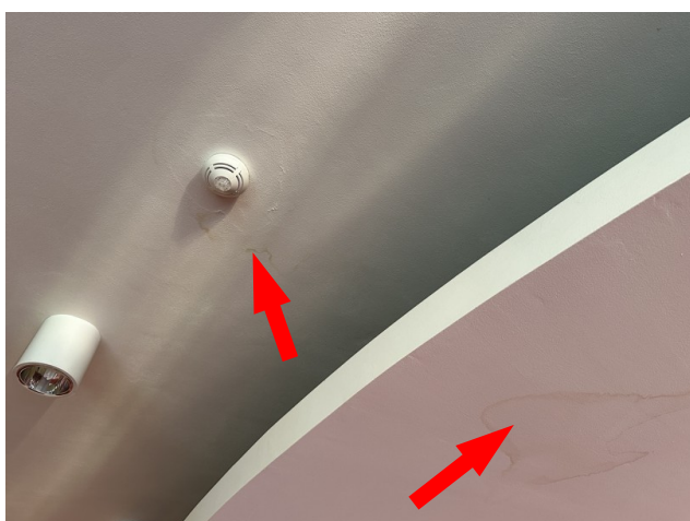
foto/3/ Pohled vlhkostní poruchy na stropní konstrukci a SDK podhledu
