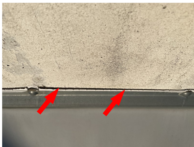
foto/24/ Pohled na ukončovací lištu svislého vytažení hydroizolační fólie – patrné netěsnosti mezi lištou a zdívem
