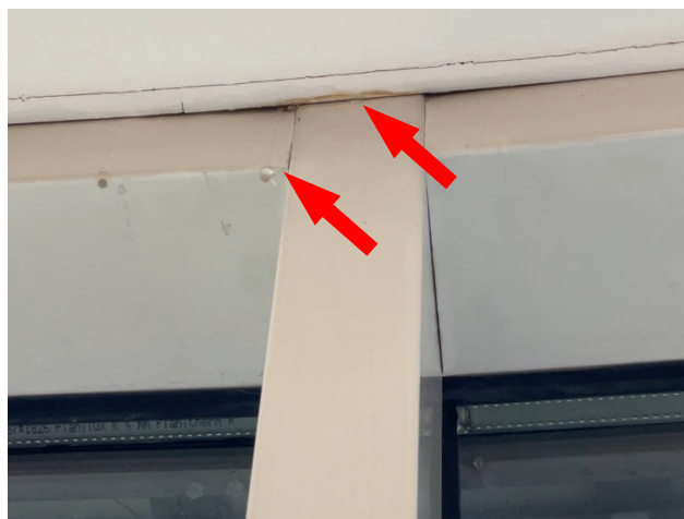
foto/48/ Pohled na vlhkostní poruchy v interiéru v místě styku rámu oken a SDK podhledu – viditelné zatékání při simulaci deště
