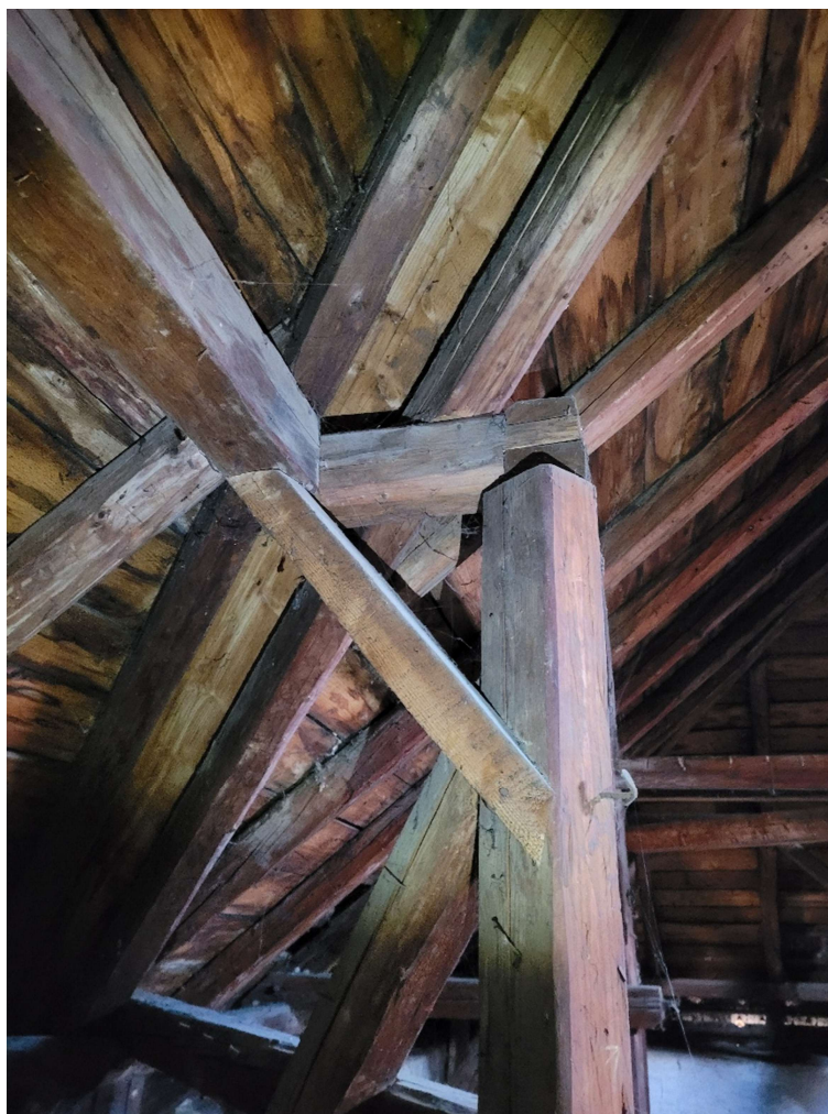
Obrázek 4 – Nevhodně řešený detail podepření konzoly podepírající vaznici
