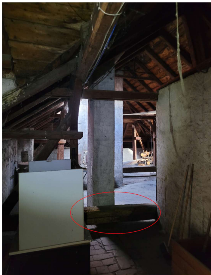
Obrázek 6 - Místo poškození vazního trámu hnilobou
