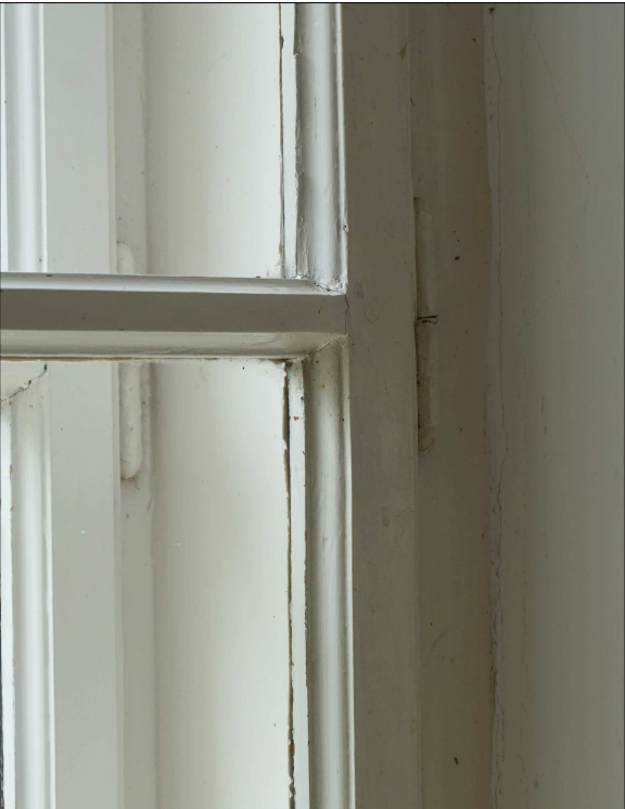
DETAIL DĚLÍCÍ PŘÍČKY A STÁČENÝCH PANTŮ
