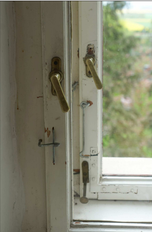
DETAIL PROFILACE KŘÍDLA A MOSAZNÝCH PŮLOLIV
