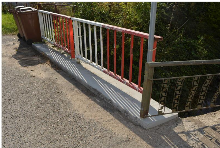
Levá mostní římsa se zábradlím od OP2.
