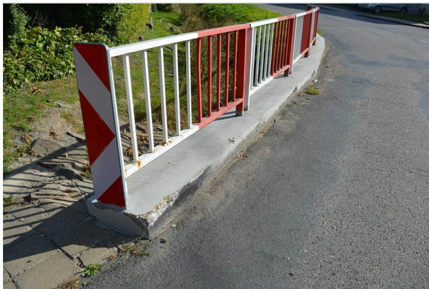
Pravá mostní římsa se zábradlím od OP2.
