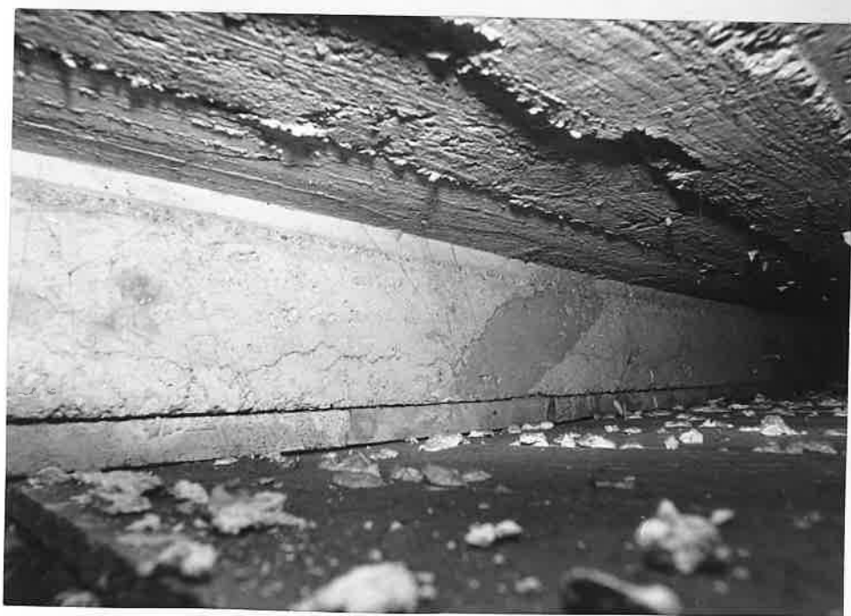
F.č.6 Sonda V 1 - na žebro jsou patrné výrazné trhliny
