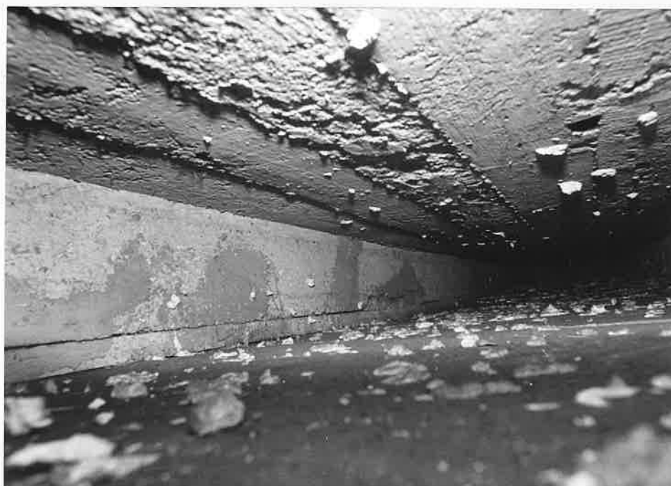
F.č.3,4 Sonda V 1 - na ŽB žebrech jsou patrné výrazné trhliny. Některé trhliny byly již v minulosti zamazány cementovým potěrem.
