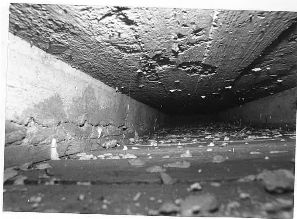
F.č.7,8 Sonda V 2 - na žebrech jsou patrné výrazné vodorovné trhliny ve stěně prvku, na některých místech se beton úplně rozpadá a dochází k obnažení výztuže.
