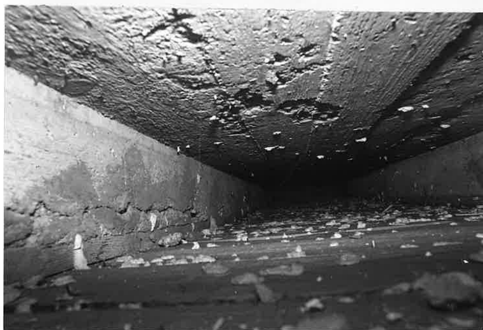
F.č.2 Sonda V 1 - výrazný průhyb stropní konstrukce.
