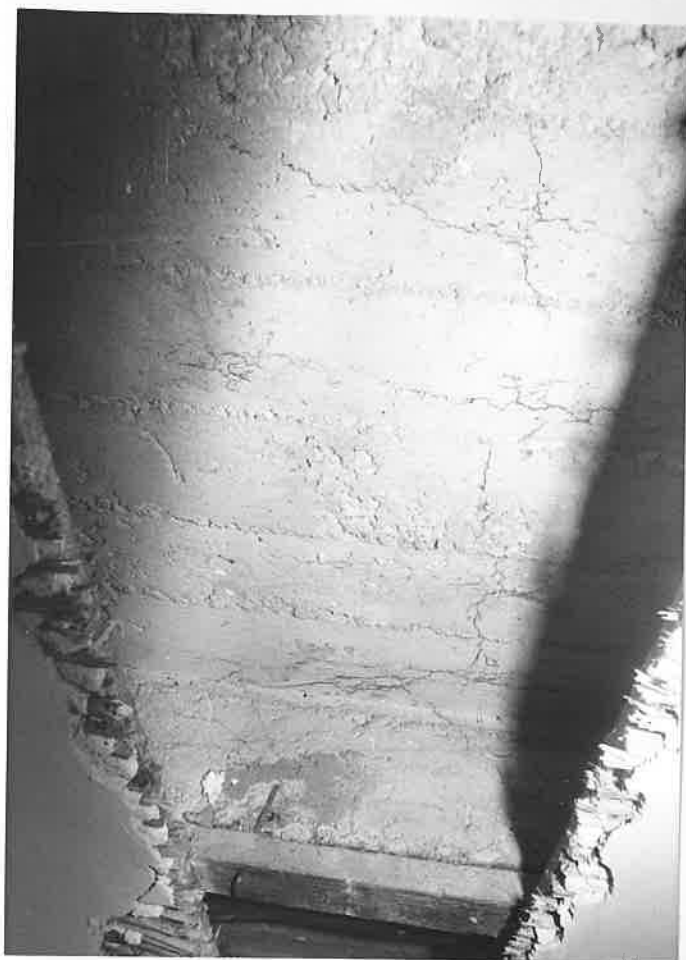
F.č.5 Sonda V 1 - pohled na desku mezi žebry narušenou trhlinami.
