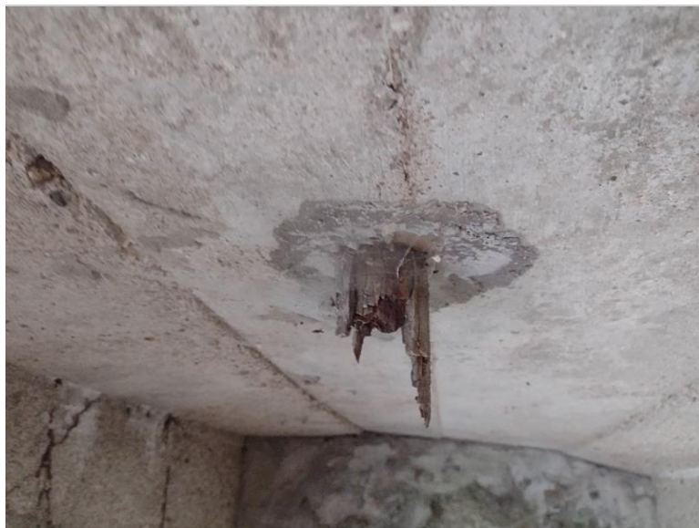
Pozůstatek odvodnění
