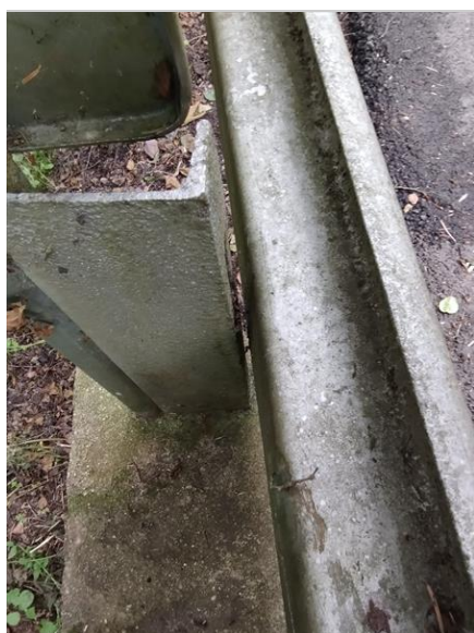
Uvolněná svodnice u OP2 vlevo
