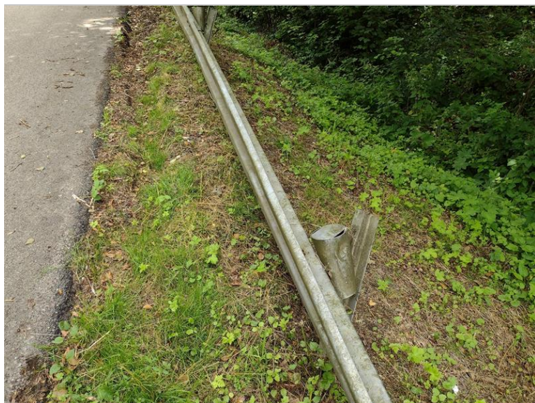
Deformace svodidla u OP2 vlevo
