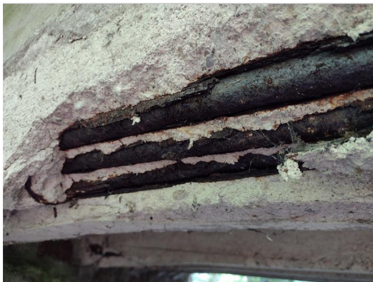
Obnažená korodující výztuž krajního trámu NK
