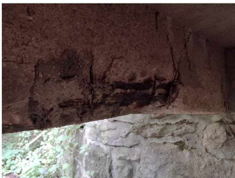
Obnažená korodující výztuž krajního trámu NK
