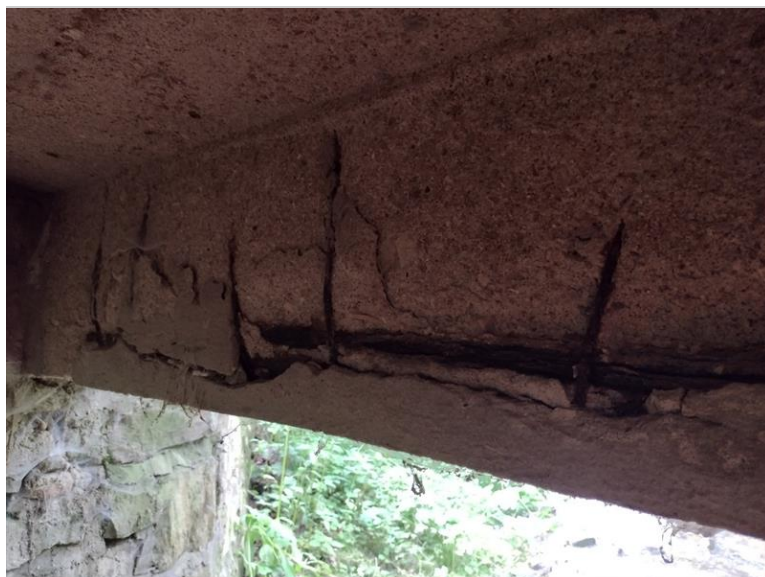
Obnažená korodující výztuž krajního trámu NK
