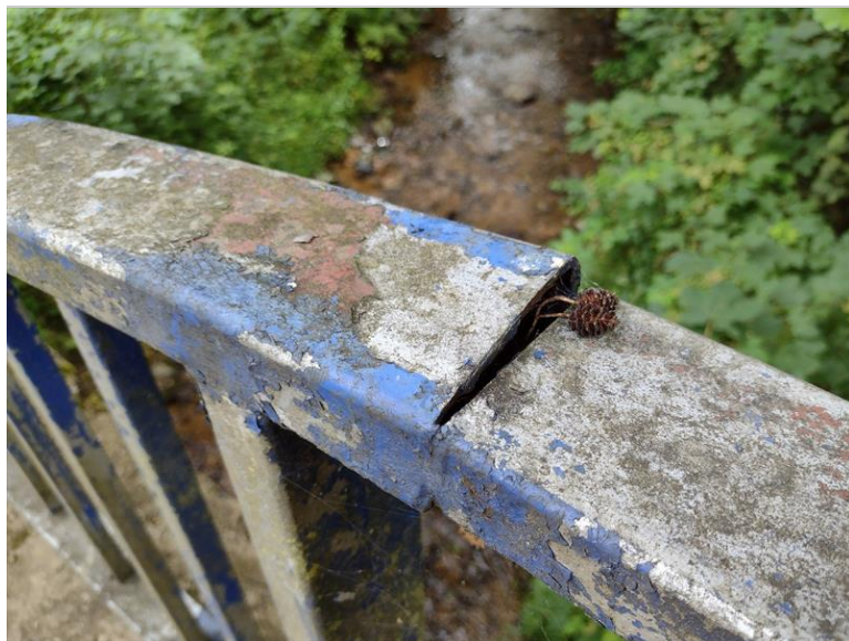
Deformace zábradlí
