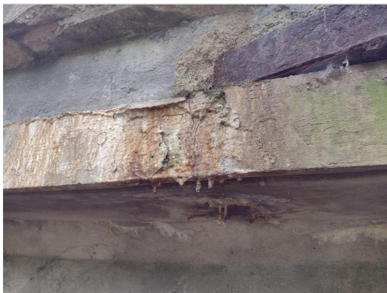
vápenné výluhy a inkrustace na NK
