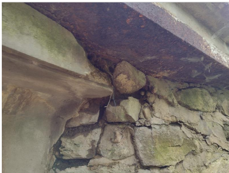
Koroze ocelových prvků u levého křídla OP1
