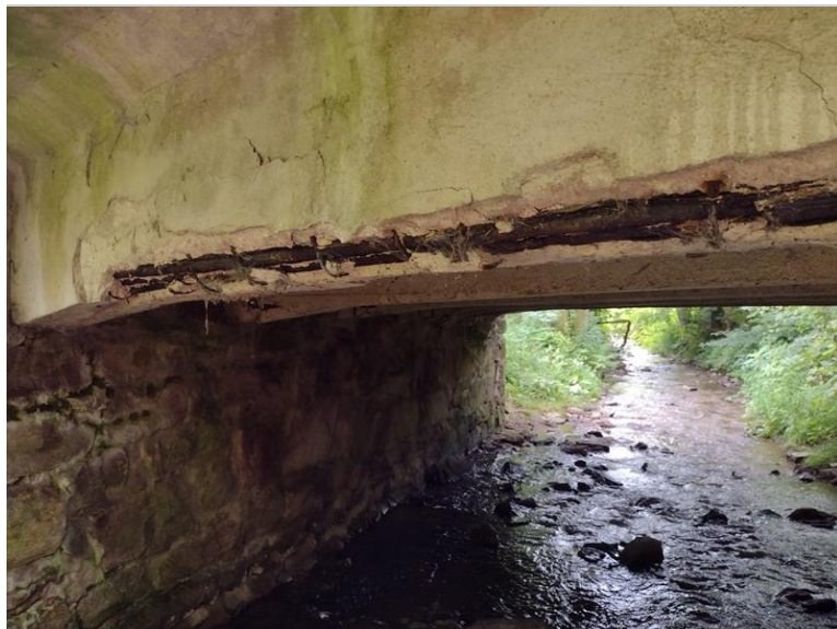
Obnažená korodující výztuž krajního trámu NK
