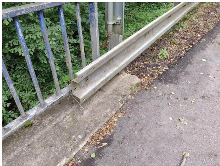
Uvolněná svodnice u OP2 vlevo
