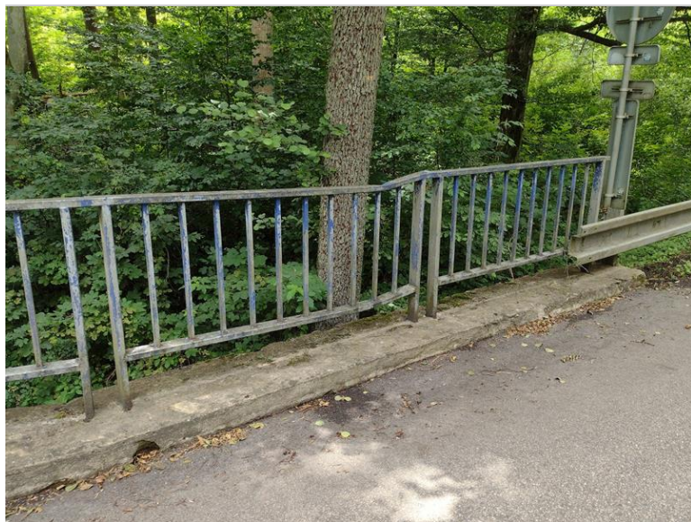
Deformace levého zábradlí
