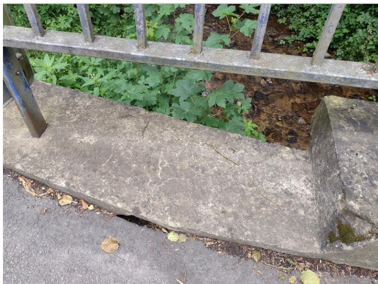
Nenormová mezera mezi zábradlím a římsou
