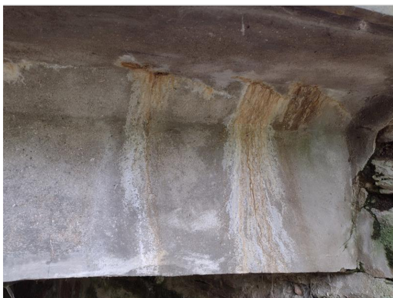
vápenné výluhy a inkrustace na NK
