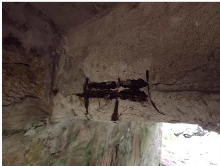
Obnažená korodující výztuž trámu NK
