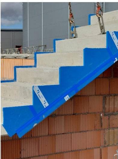
Obr. 12: Příklad schodišťového systému ochrany proti kročejovému zvuku [zdroj: https://www.schoeck-wittek.cz/ a vlastní]
