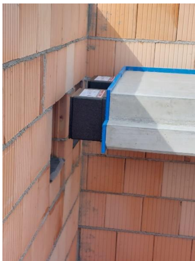
Obr. 12: Příklad schodišťového systému ochrany proti kročejovému zvuku [zdroj: https://www.schoeck-wittek.cz/ a vlastní]
