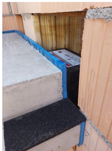
Obr. 12: Příklad schodišťového systému ochrany proti kročejovému zvuku [zdroj: https://www.schoeck-wittek.cz/ a vlastní]
