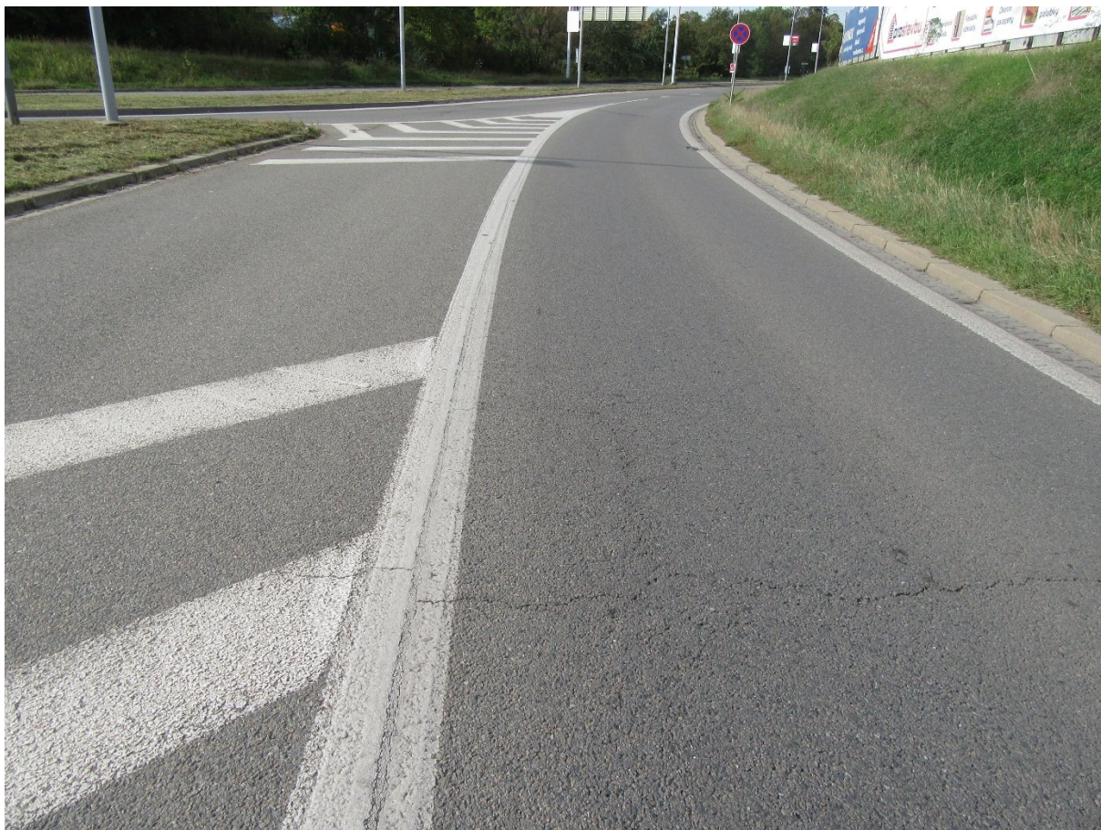
Rampa PP, km 0,035+ Příčná rozvětvená trhlina.
