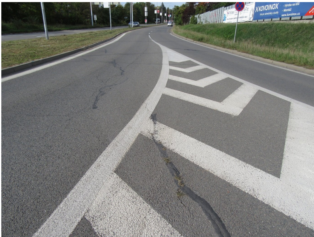
PP, km 0,041+ Mozaikové, příčné, podélné a nepravidelné rozvětvené trhliny, místy ošetřené zálivkou, ztráta asfaltového tmelu.
