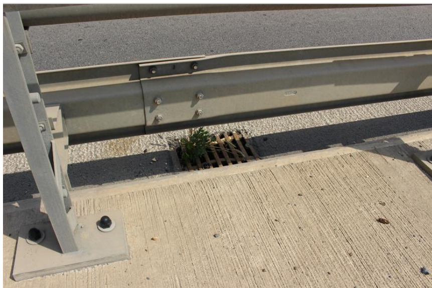
07-detail odvodňovače s vegetací.JPG
