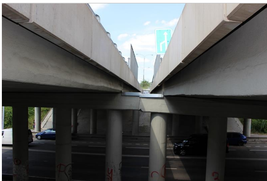
17-zrcadlo mezi sousedními objekty- pilíř P3.JPG
