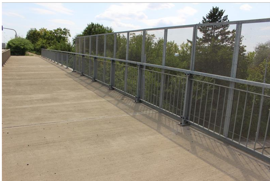
06-pohled na zábradlí a zábranu proti dotyku.JPG
