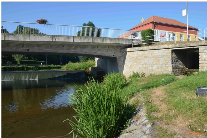
Pohled na rámovou stojku P1 zleva. U levého křídla vyústění zatrubnění toku.
