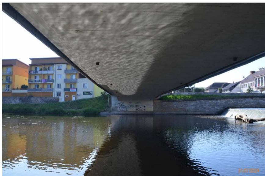
Podhled nosné konstrukce. Pohled po směru staničení. 2 svody odvodnění neprotáženy pod líc NK.
