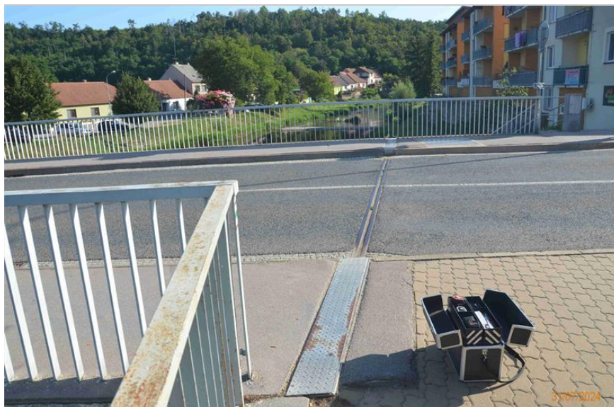
Celkový pohled na mostní závěr nad stojkou OP2 zprava. V závěru uchycena drobná vegetace. Ocelové profily lokálně korodují. Dlažba chodníku u MZ vpravo na OP2 propadlá.
