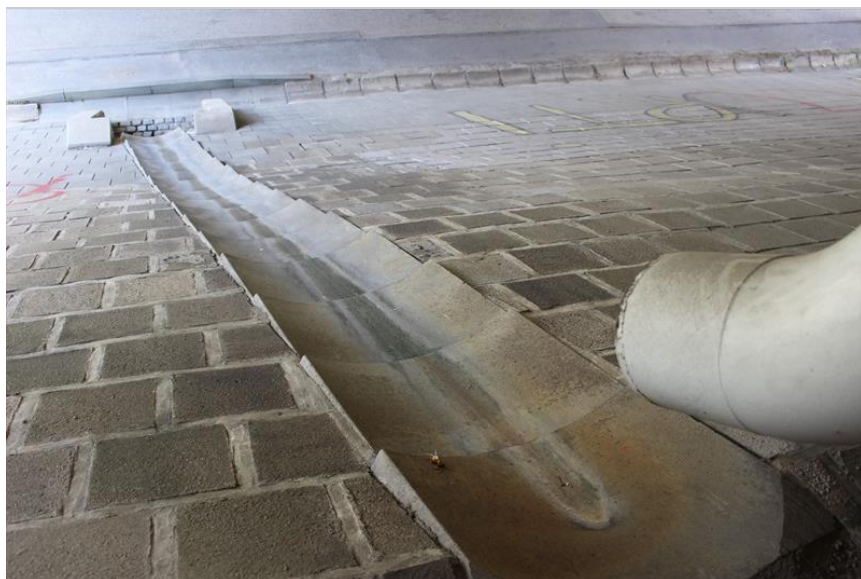
21-vyústění odvodňovače a skluz u opěry 4.JPG
