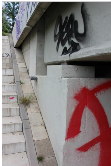
10-uložení krajního nosníku na opěře 1.JPG
