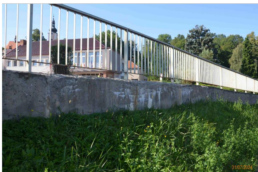
Detail stavu koruny nábrežní zdi vpravo u stojky OP2. V povrchu betonu patrná síť trhlin doprovázená vápennými výluhy a výluhy rzi.
