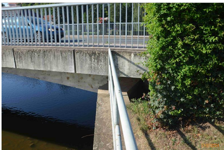
Detail napojení nosné konstrukce na rámovou stojku P1 vlevo. Na svislém povrchu římsy patrné stopy stékání vody.
