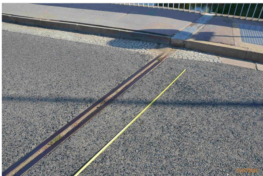
Detailní pohled na stav vozovky v předpolí mostu u podpěry OP2. Ve vozovce v předpolí mostu otevřená trhlina rovnoběžná s mostním závěrem
