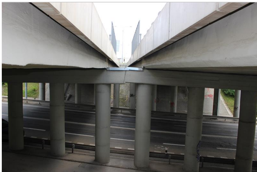
13-zrcadlo mezi sousedními objekty- pilíř P2.JPG
