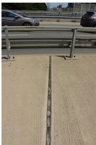
05-detail dilatační spáry v římse nad pilířem P2.JPG
