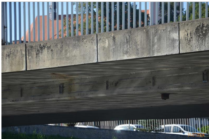
Detailní pohled na povrch levé římsy a podhled konzoly vlevo cca ve středu rozpětí s patrným železitým výluhem a odprýsknutou krycí vrstvou výztuže na podhledu konzoly. Na bočním lici NK nainstalováno zařízení pro dlouhodobé sledování deformace mostu.
