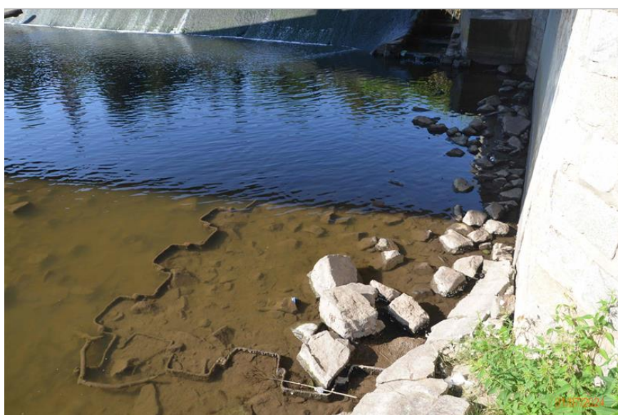
Štětovnice v patě stojky OP1. Kamenný zához částečně chybí.
