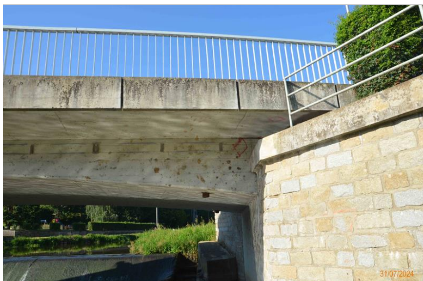
Detail napojení nosné konstrukce na rámovou stojku OP1 vlevo. Svislé svody odvodnění korodují. Koroze doprovázena tvorbou a odlupováním korozních zplodin.
