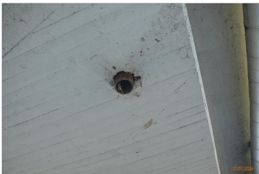
Detail podhledu nosné konstrukce u podpěry OP1 vpravo. Na fotografii patrné štěrkové hnízdo a koroze svislé části svodu.
