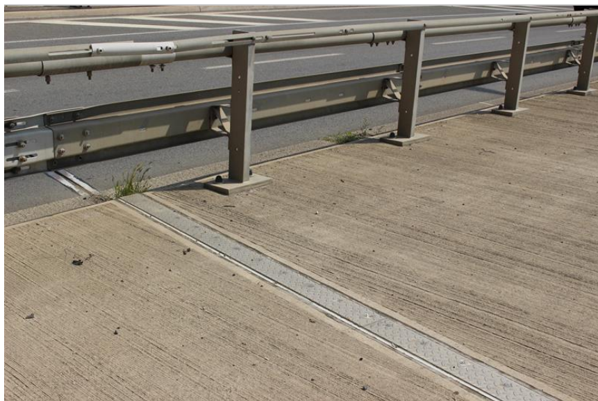
05-detail dilatační spáry v římse nad pilířem P2.JPG
