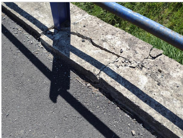
trhliny v pravé římse
