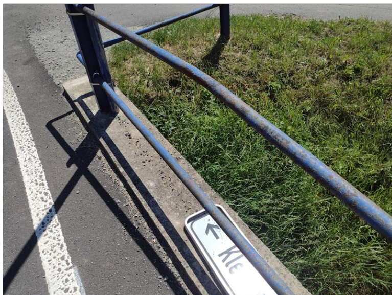
Deformace pravého zábradlí
