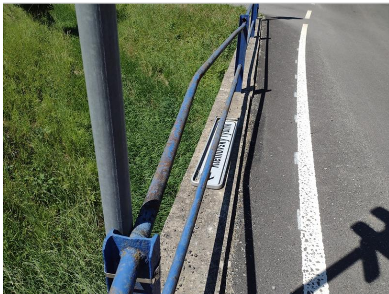
Deformace pravého zábradlí
