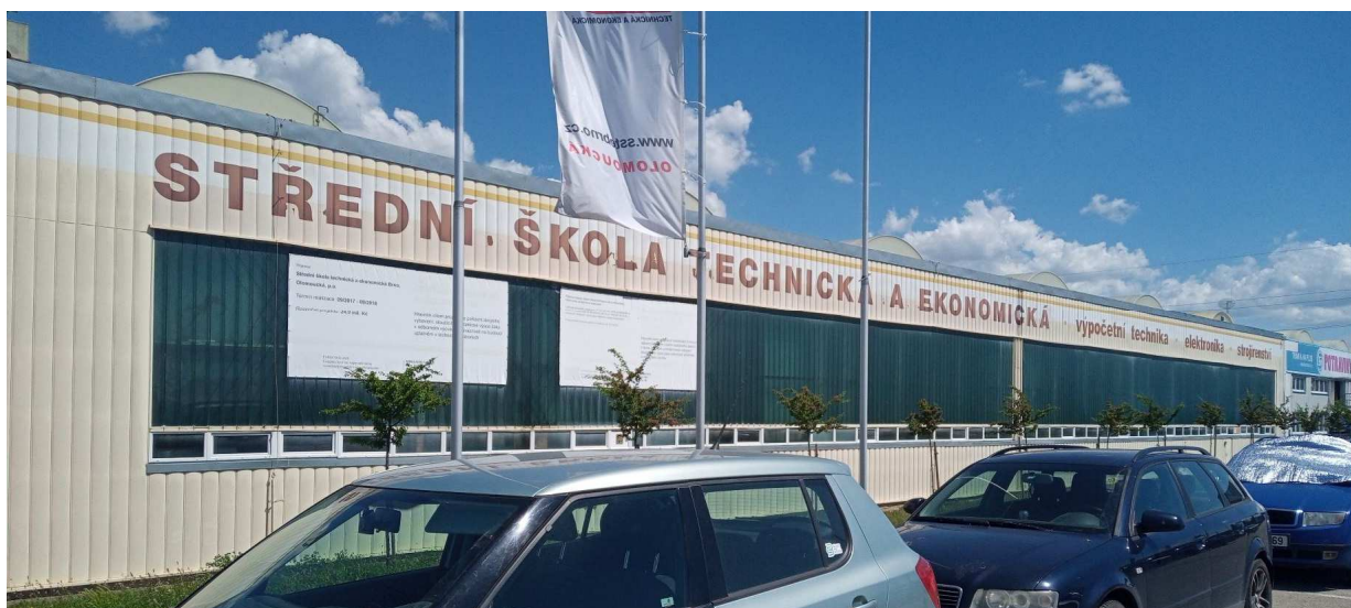
Obr. 1. Hala SŠTE Brno, Olomoucká 1140/61, pohled z jihozápadní strany.
