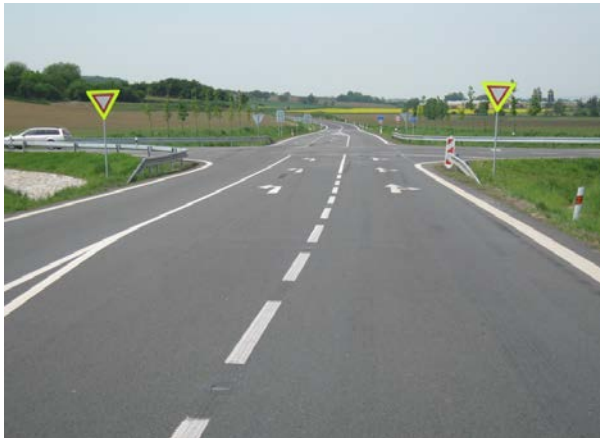
Obr. 6 – Křižovatka silnic I/47 a II/367 po modernizaci
