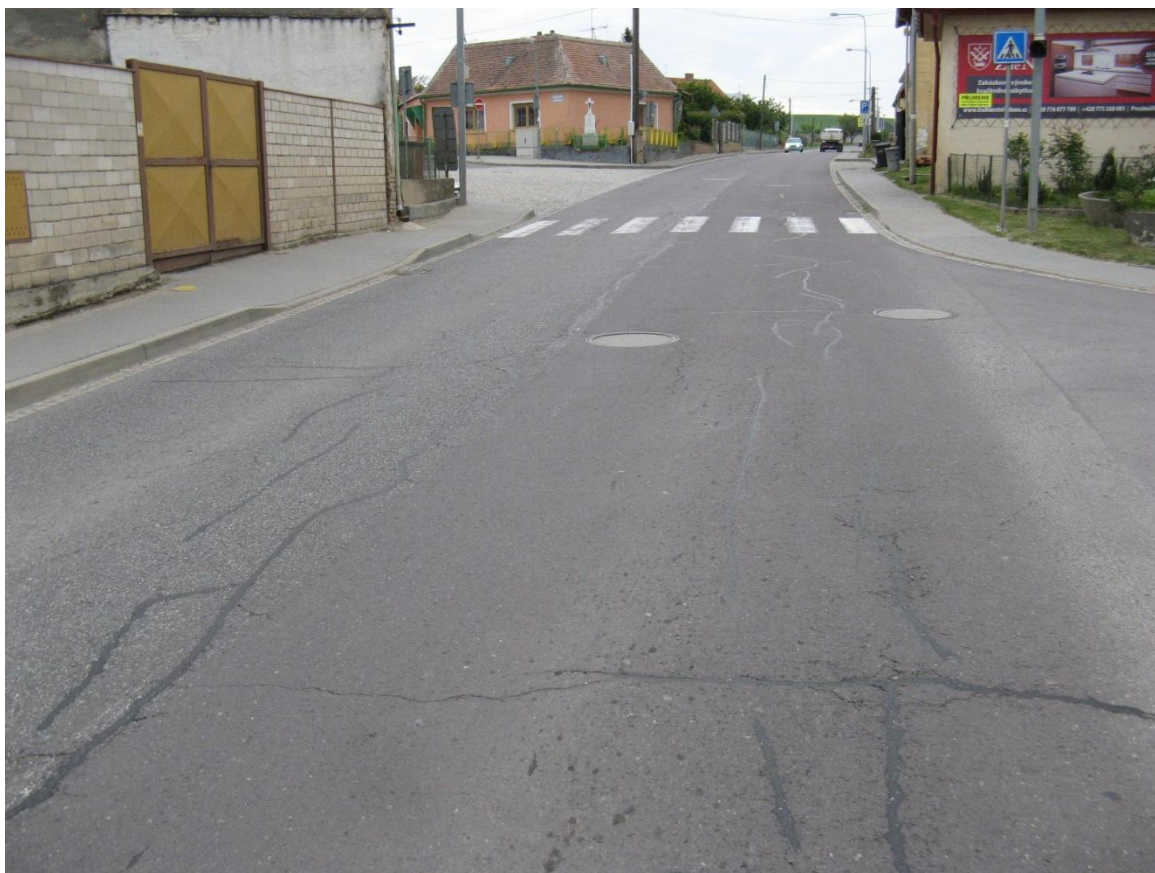
F11, km 68,710+ Nepravidelné rozvětvené trhliny.
