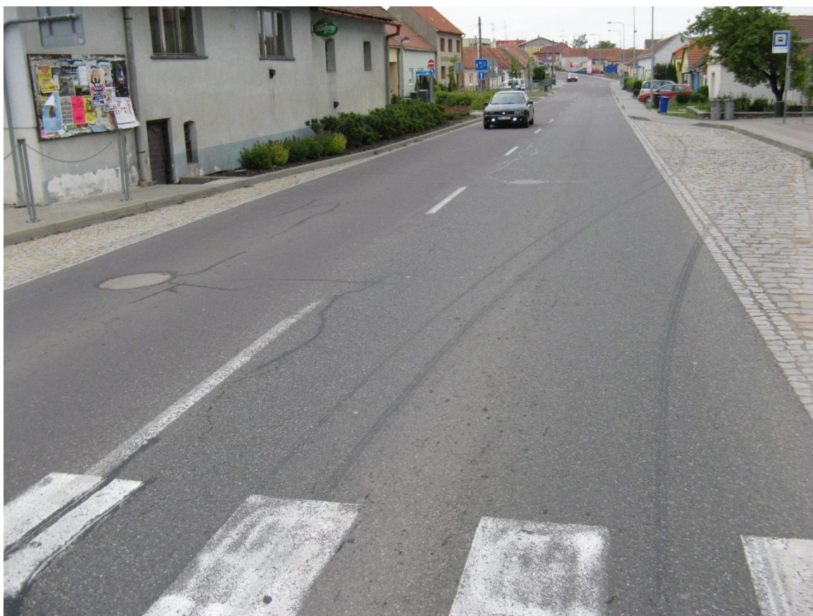
F08, km 68,510+ Nepravidelné trhliny.
