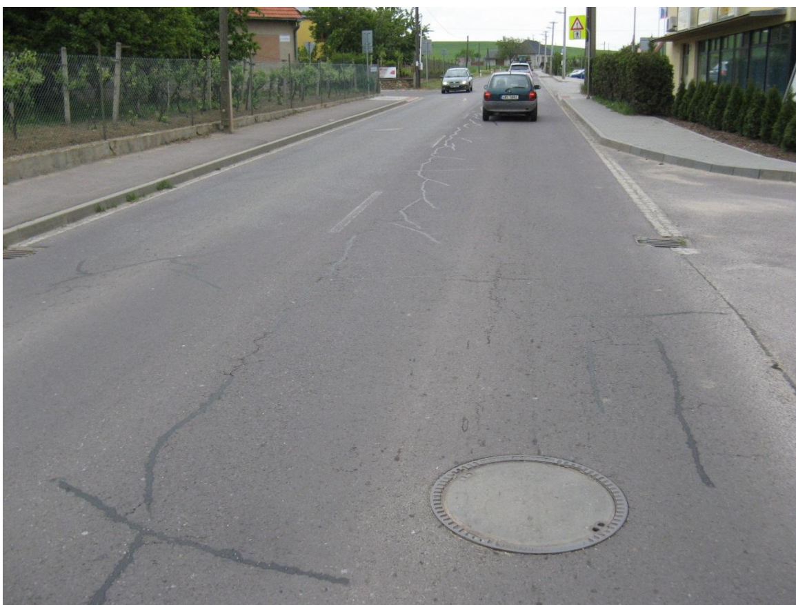
F13, km 68,810+ Nepravidelné rozvětvené trhliny.
