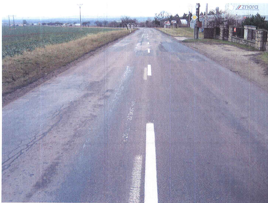
F4, km 70,592 síťové trhliny, deformace, vysprávk
