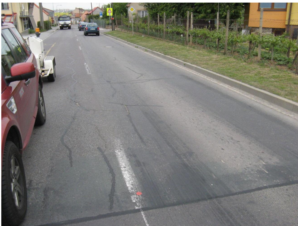
F14, km 68,910- Nepravidelné rozvětvené trhliny.
