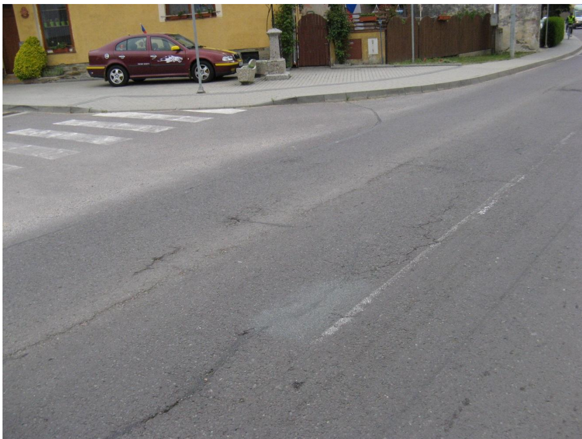
F03, km 68,110+ Nepravidelné trhliny.
