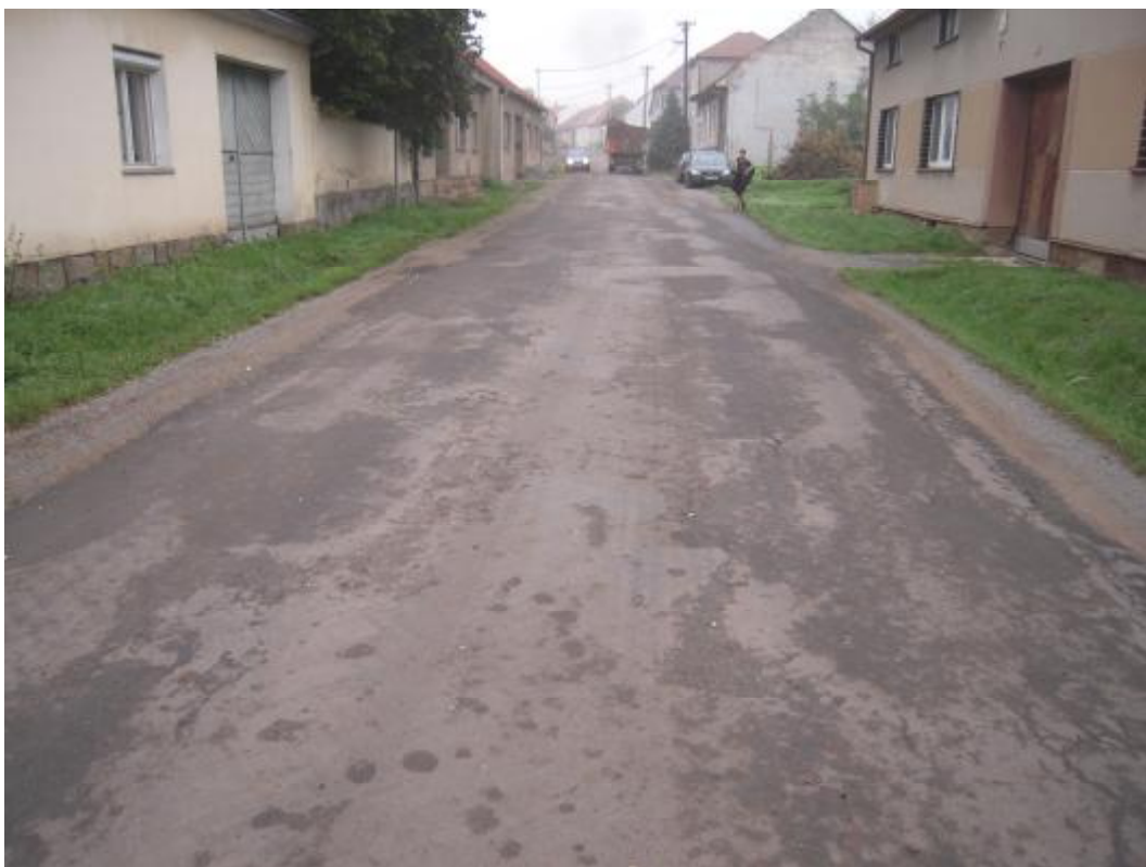
F23 – Silnice III/37414, km 2,410+; nepravidelné hrboly a trhliny, plošná deformace
