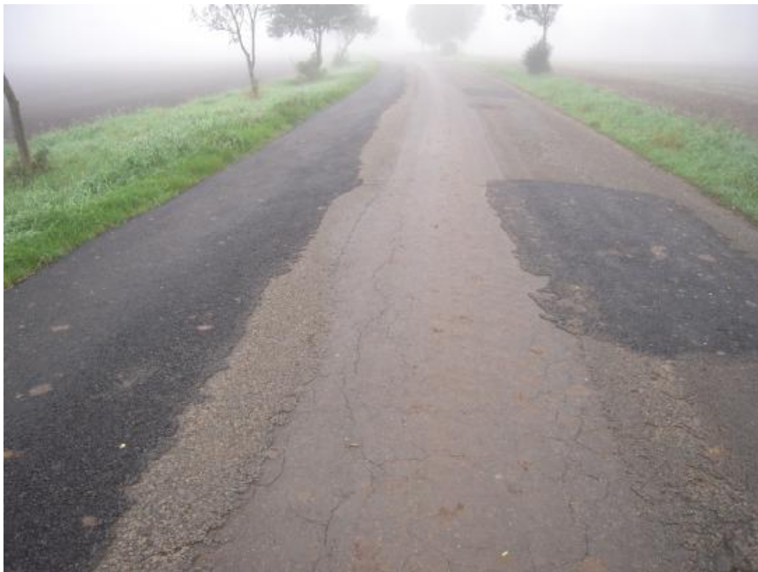
F12 – Silnice III/37413, km 0,810+; vysprávký okrajů, síťové trhliny
