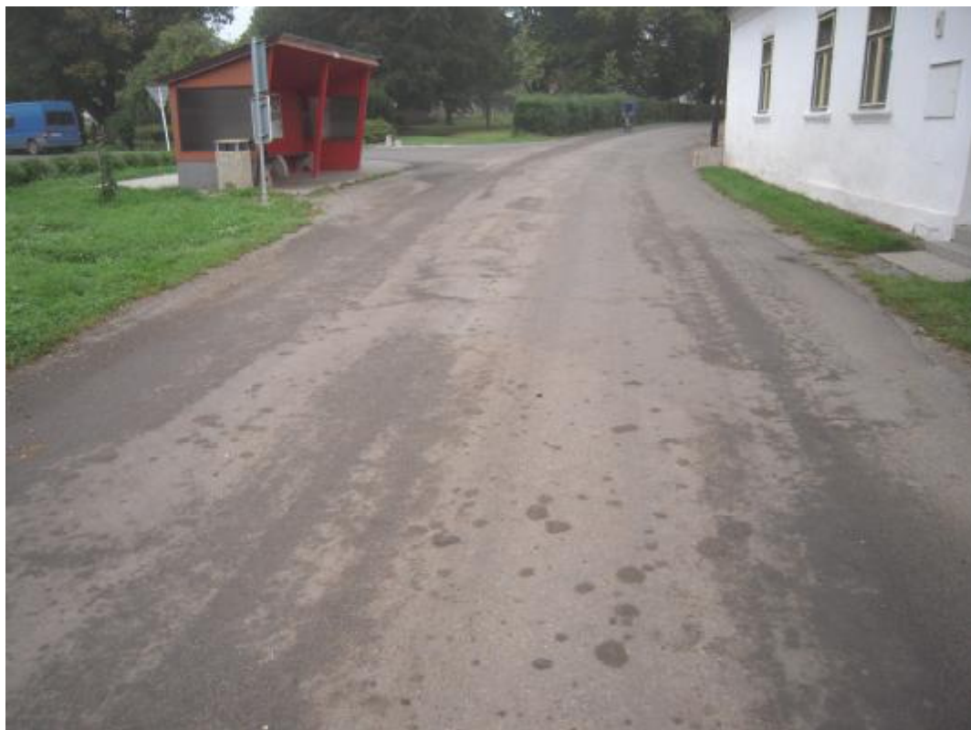
F26 – Silnice III/37414, km 2,610+; vysprávkky, trhliny a deformace (vyjeté koleje)
