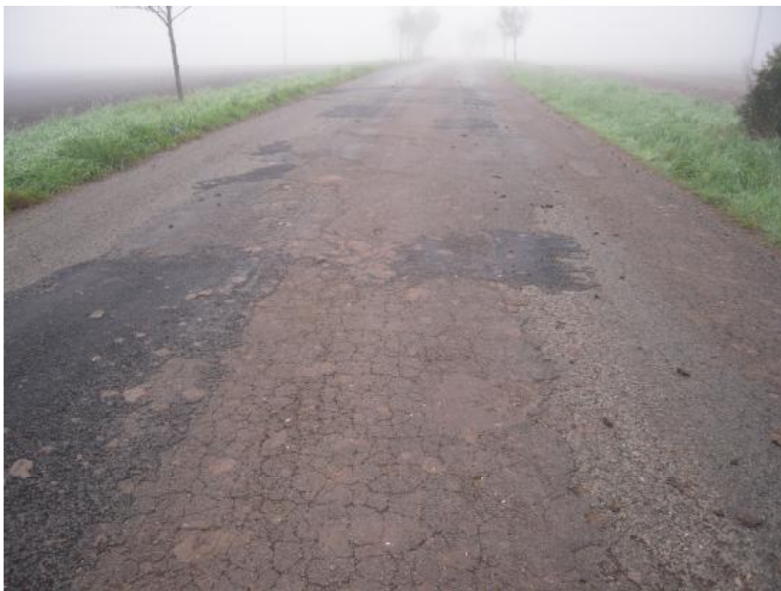
F07 – Silnice III/37413, km 0,410+; celoplošné konstrukční porušení vozovky
