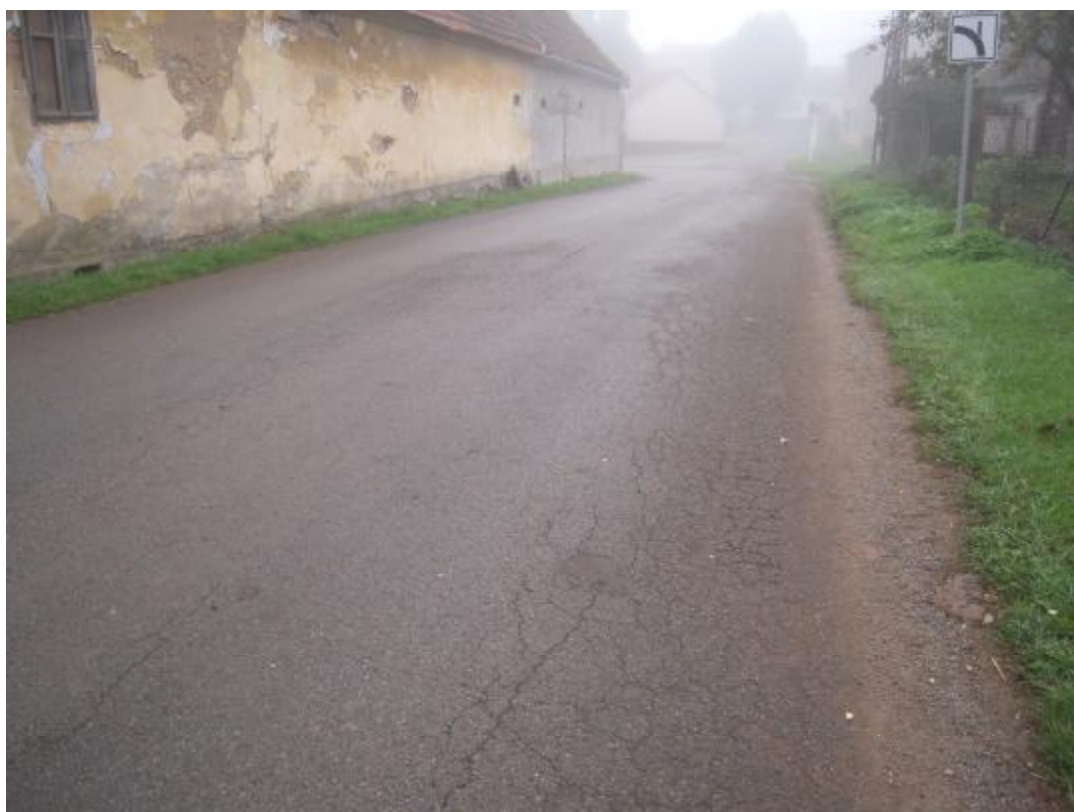
F16 – Silnice III/37413, km 1,210+; síťové trhliny u okrajů (v obci Sudice)
