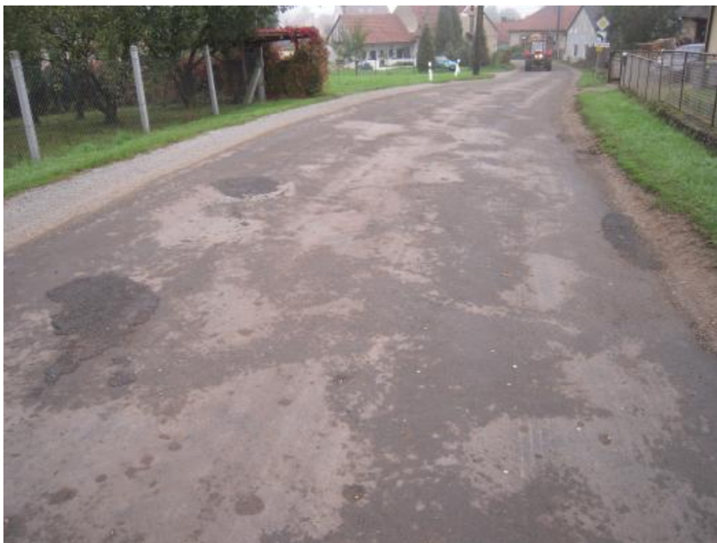
F21 – Silnice III/37414, km 2,210+; nepravidelné hrboly a trhliny, plošná deformace
